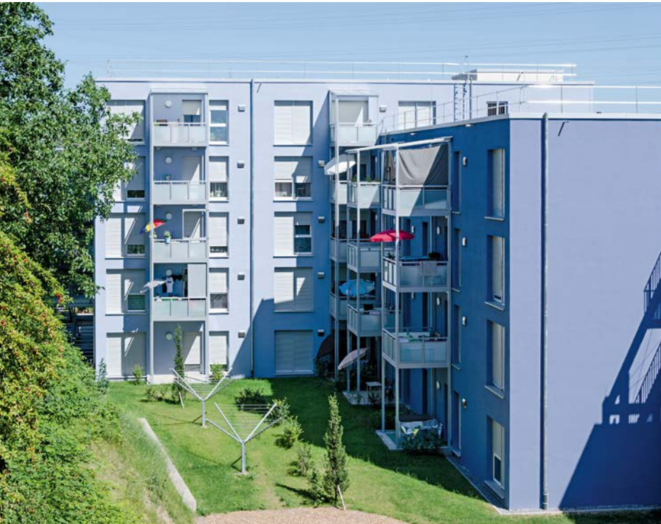
Alle Geräte sind direkt in der Außenwand platziert, die Ablufträume Küche und Badezimmer sind über kurze Luftkanäle angeschlossen
