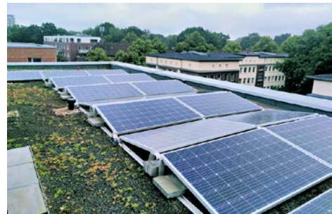
Auf den Dächern des Neubauprojekts Barmbek Family im Wittenkamp wurden im August 2019 die ersten Photovoltaikanlagen montiert
