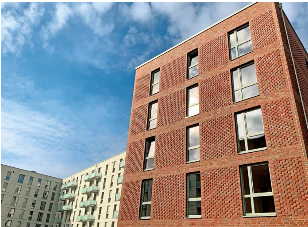
Die Wohnungen sind überwiegend für Familien geplant und haben ein bis vier Zimmer: Inzwischen sind alle Gebäude vollständig abgerüstet und die Ausbauarbeiten in den letzten Zügen
