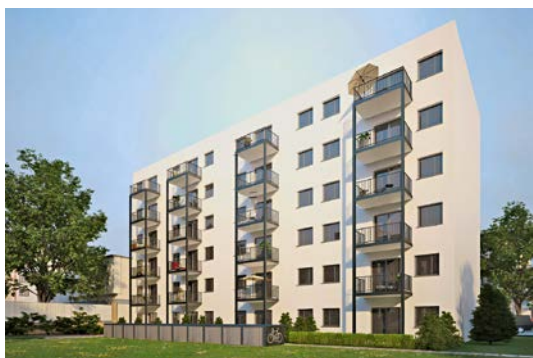
Durch die vorgefertigten Module verkürzt sich die Bauzeit
