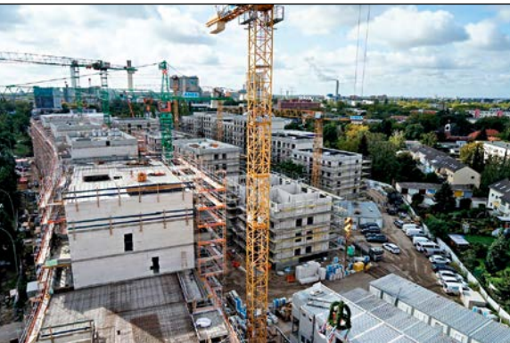
Die Baustelle des Quartiers Paulsternstraße am Tag des Richtfestes Mitte September
