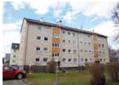
Die Gebäude in der Reichenberger Straße vor und nach der Modernisierung
