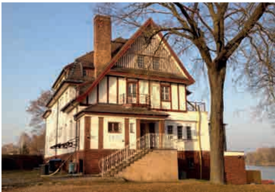
2010 ersteigerte die Wiwo das 1925 errichtete Wassersportklubhaus von einem privaten Eigentümer. Für 3 Mio. € soll jetzt daraus ein Ausflugsrestaurant mit Veranstaltungsbetrieb werden
