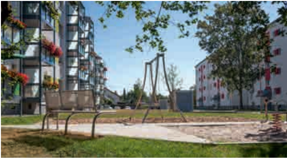
Wohnanlage in der Kallstadter Straße: Auch in frisch sanierten Beständen geht mal was kaputt - eine gute Handwerkerkopplung hilft, die Qualität hoch zu halten
