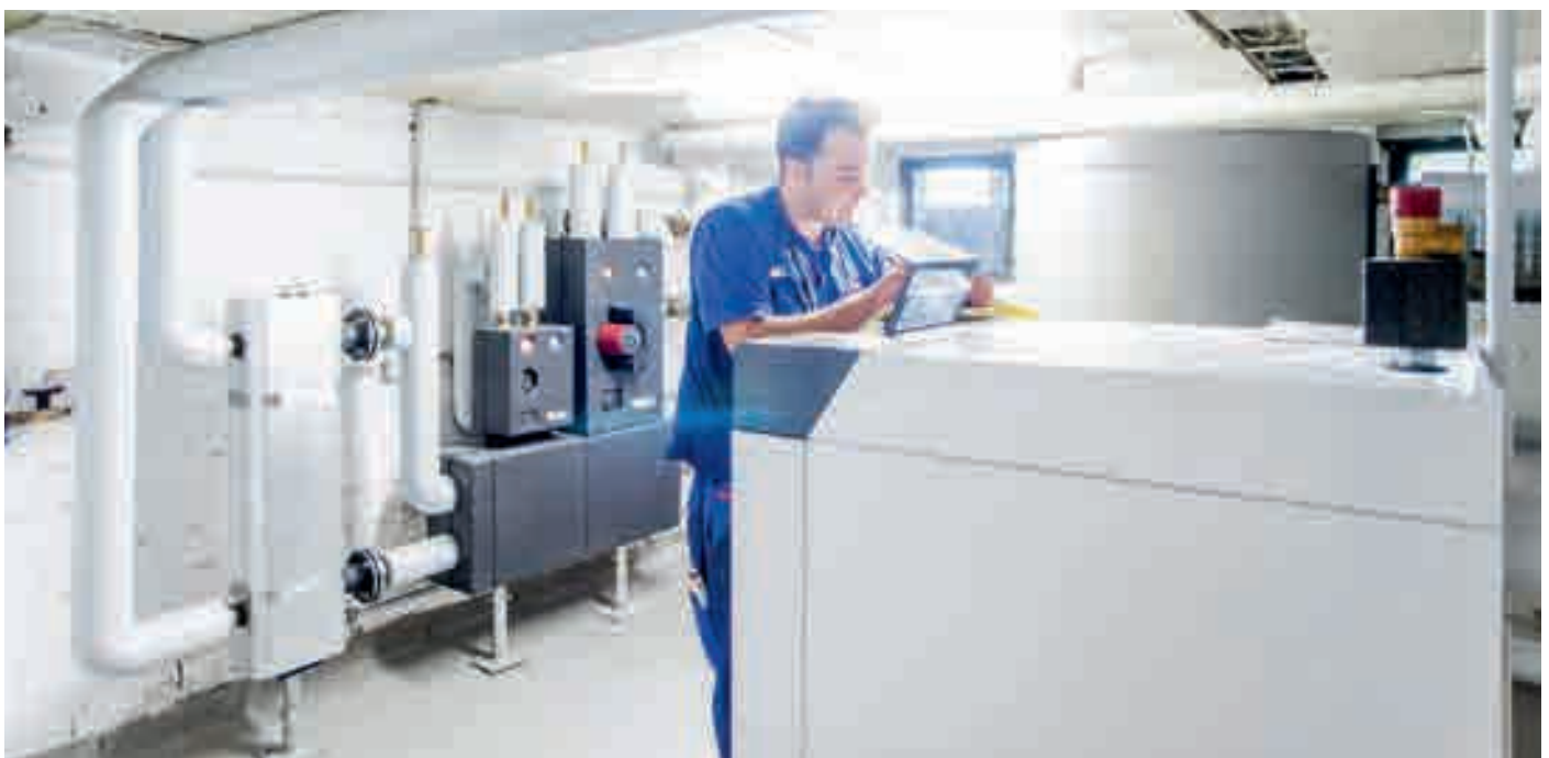
Bei der Modernisierung legt die Wohnungsgenossenschaft Witten-Mitte großen Wert auf Energieeffizienz. In die Jahre gekommene Heizkessel werden systematisch durch moderne Anlagen ersetzt
