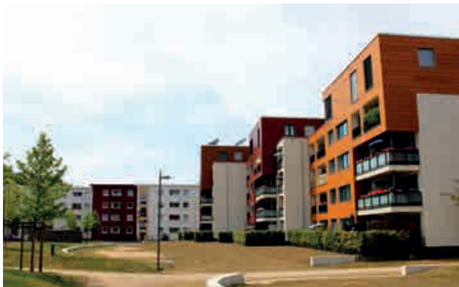
Revitalisierung in der Siedlung Neue Burg - rechts im Bild die Gebäude des 1. Bauabschnitts, hinten die des 3. und 4. Bauabschnitts
