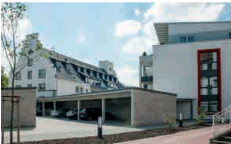
Ansicht vom Ostertorwall auf das Quartier. Die Carportanlage dient als Emissionsschutz
