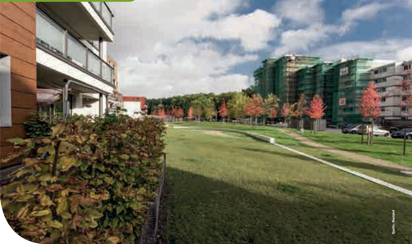
Wohngebiet Neue Burg - Modernisierung im 3. und 4. Bauabschnitt
