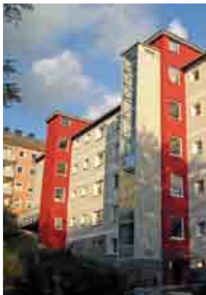
Die Baukosten für die Aufzugsanlage betragen 150.000 Euro. Quelle: IGW
