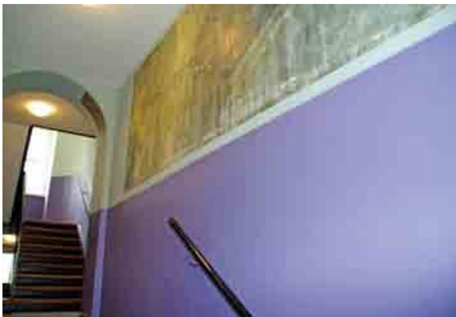
Treppenhaus in der Renkwitzstraße 6: Das obere Stück zeigt den Originalzustand aus dem Jahre 1922. Bei der Sanierung 2003 entschied man sich für ein kräftiges Lila. Foto: Heidrun Böger
