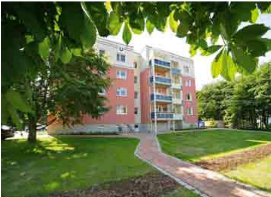
Modernisiertes Haus in der Graal-Müritzer Dr.-Leber-Straße 5. Quelle: WG S-H, Foto: Fotostudio Hagedorn Rostock
