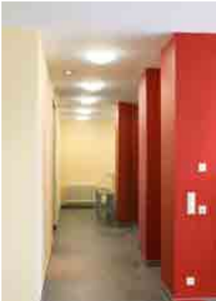
Die Ausleuchtung von Nischen erhöht das Sicherheitsgefühl. Wartungsarme 74er LEDs bieten sich an. Quelle: Trilux
