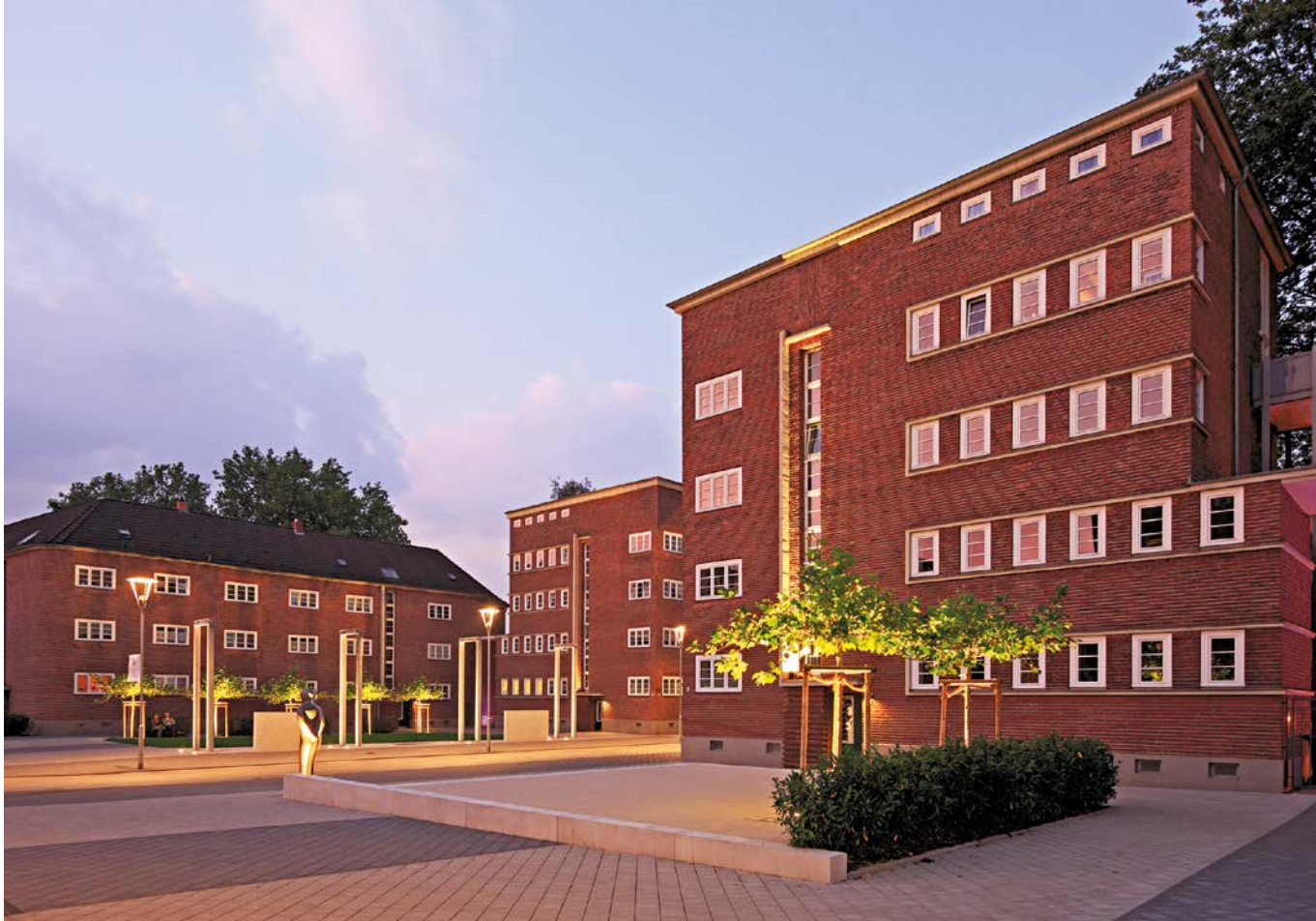
Um die architektonisch bedeutenden Gebäude zu erhalten und zugleich modernen Wohnstandards anzupassen, wurden in den Jahren 2003 bis 2006 aufwendige Modernisierungs-, Um- und Ausbaurbeiten vorgenommen, die viele historische Details berücksichtigten
