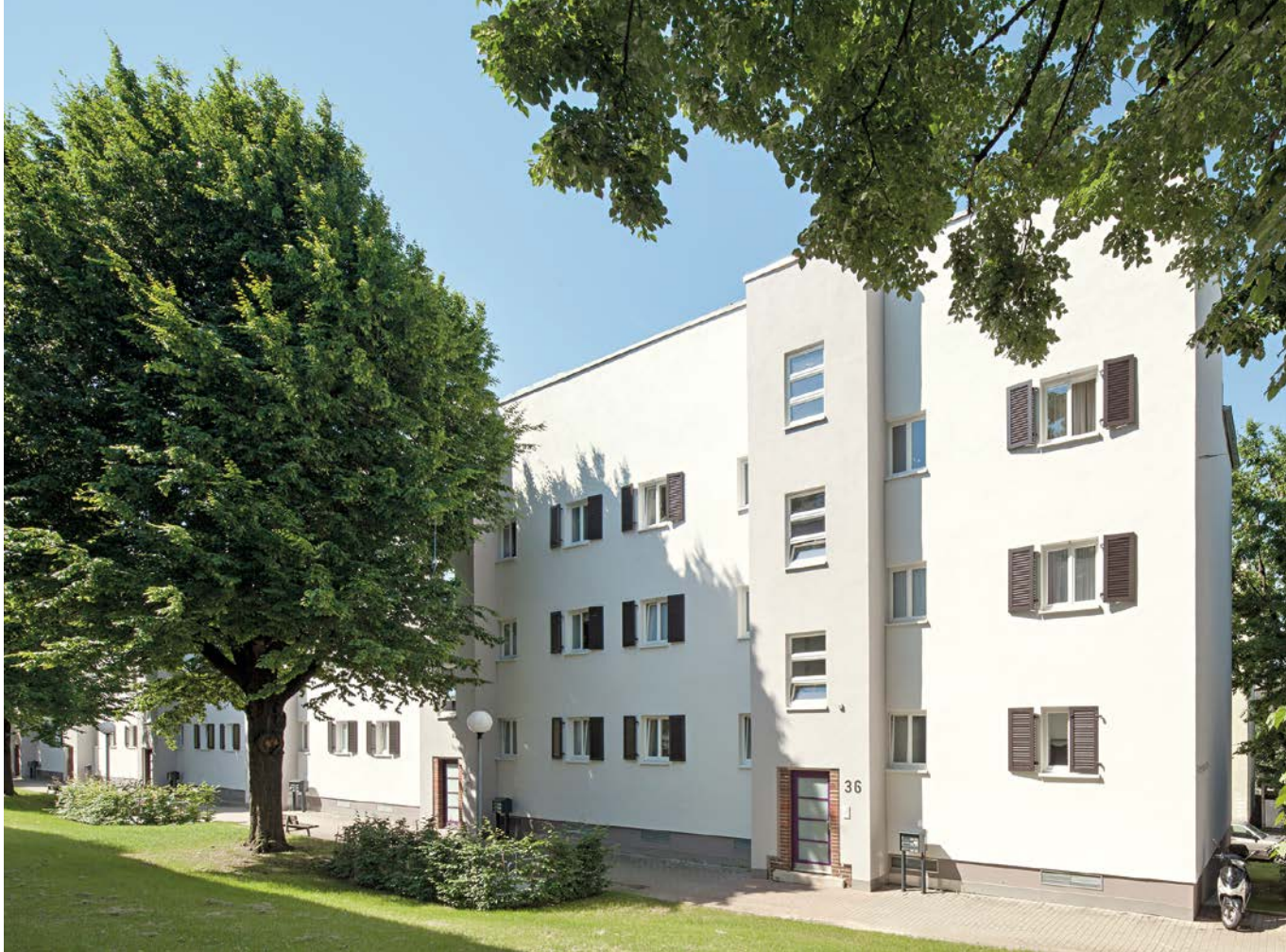
Denkmalgeschütztes Bestandsgebäude aus den 1930er Jahren in der Wallmerstraße in Stuttgart-Untertürkheim, das bereits mit der neuen Technik ausgestattet ist
