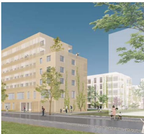
75 öffentlich geförderte Wohnungen in nachhaltiger und ökologischer Bauweise errichtet die FSB in Freiburg
