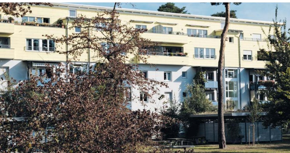
Das größte bislang recherchierte Aufstockungsvorhaben in Holzbauweise mit 526 Wohneinheiten wurde im Jahr 2000 in der Karlsruher Nordstadt fertiggestellt
