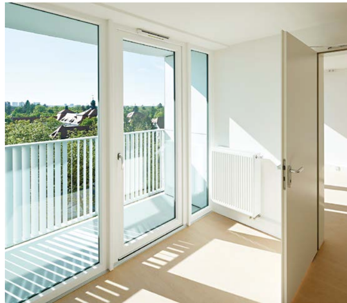
Durchbrüche ermöglichen größere Familienwohnungen, neue Fenster sorgen für eine bessere Energiebilanz
