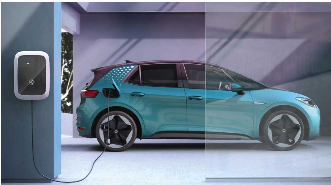
Das E-Auto bequem zu Hause laden – bald Standard? Die Wohnungswirtschaft nimmt hier eine Schlüsselposition ein: Ladestationen müssen installiert werden, mit neuen Anforderungen an den Brandschutz und Stromleitungen
