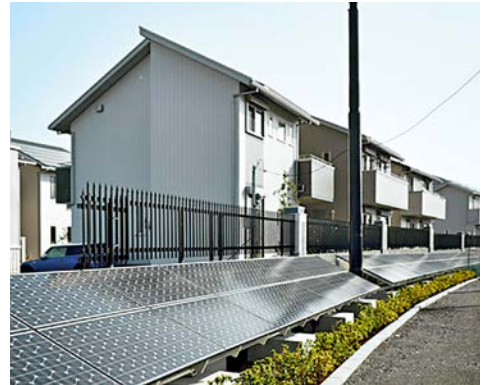
Auf einer Länge von rund 400 m säumen Solarmodule die Straßen und ermöglichen eine nahezu autarke Stromversorgung
