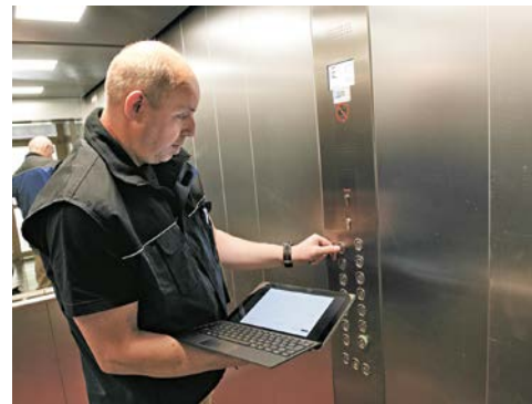
Der Haustechniker kann in der Fresh-Energy-App den Verbrauch des Aufzugs direkt während der Fahrt ablesen
