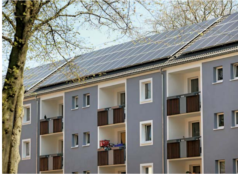
Photovoltaik liefert den Strom und das Siedlungsmanagement sorgt dafür, dass Verbrauch und Erzeugung optimal aufeinander abgestimmt sind
