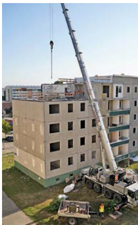
Plattendreher am Werk Ein großer Kran hebt die ersten Platten des Aufgangs Nummer 4 vom ehemaligen Wohnhaus des Typs WBS 70 ab.
