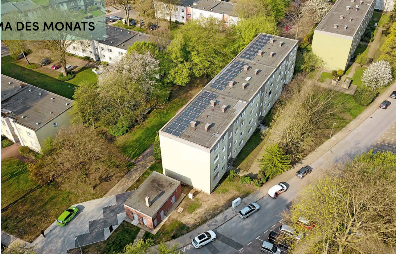
Gebäude der Mülheimer Wohnungsbau eG mit PV-Anlage, neuer Wärmezentrale mit Lademöglichkeit für Pedelecs und E-Carsharing-Fahrzeuge (unten im Bild)
