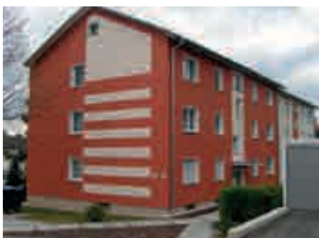
Kopffassade in der Sudetenstr. 16-18 nach der Modernisierung 2011
