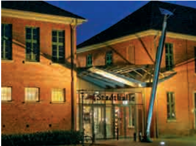
Quelle: Stadthalle Verden
