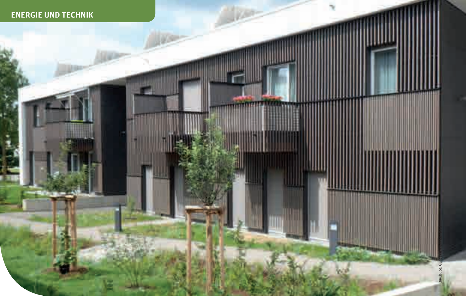
Eine thermische Solaranlage stellt das Herzstück des Neubaus dar, den das St. Gundekar-Werk Eichstätt in Ingolstadt-Hollerstauden errichtet hat.
