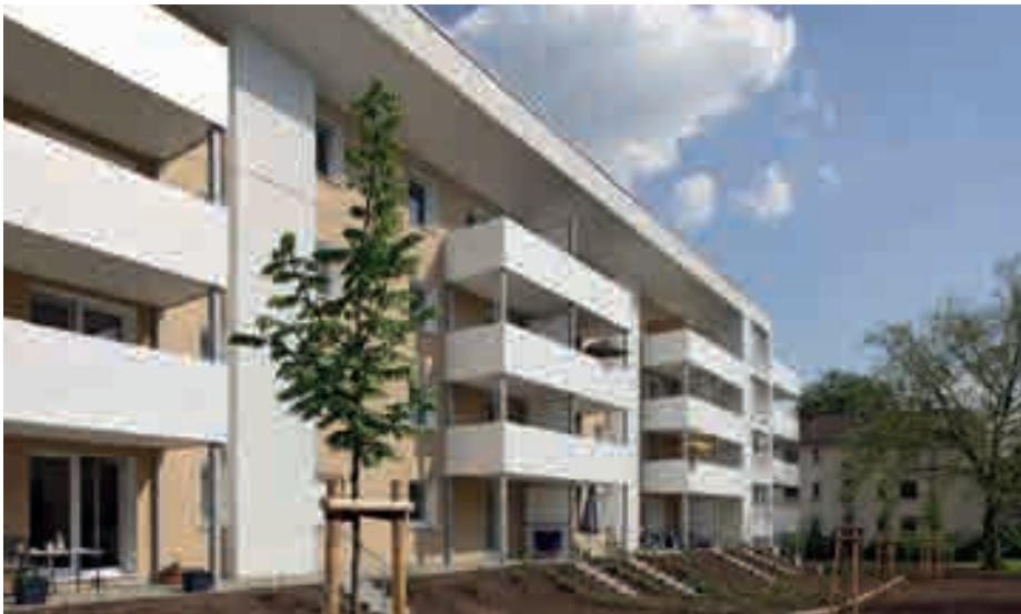
Mehr Platz ohne Enge: Im Rahmen des Quartiersumbaus in der Holzhofallee/Schepp Allee gelang eine moderate Verdichtung durch Aufstockung von Bestandsgebäuden.
