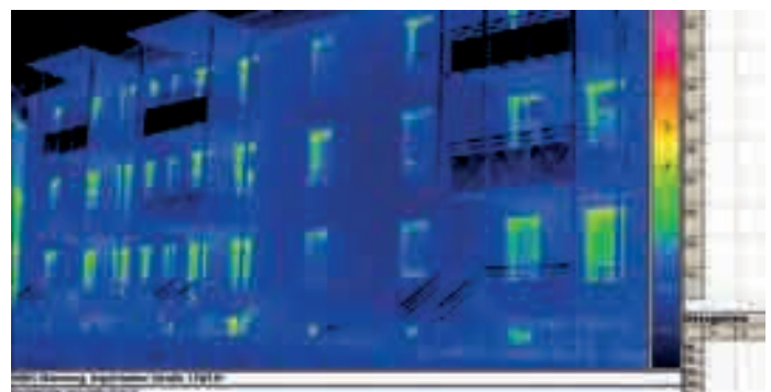
...die dazu gehörende Thermografieaufnahme der Fassade
