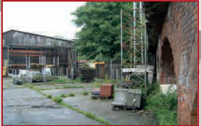
Zustand des Baugrundstücks vor der Bebauung
