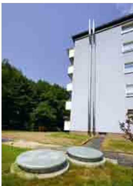
Zu jeder Nahwärmezentrale gibt es einen leicht anzufahrenden Erdbunker für Pellets.
