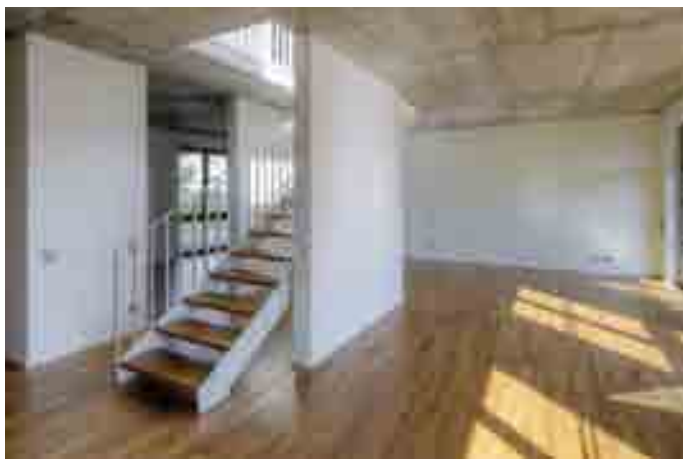
In den großen und exklusiven Wohnungstypen im Nordflügel wurden Sichtbetonwände oder -decken bewusst als Designelement eingesetzt.
