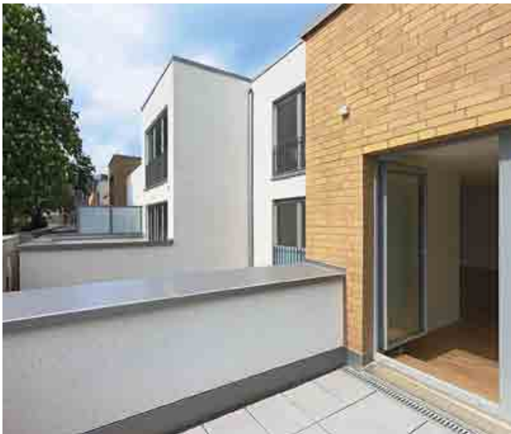
Alle Wohnungen verfügen über große Terrassen oder Balkone. Die erhaltene Umfassungsmauer der alten Stallungen, hier links im Bild zu erkennen, wird durch einen Betonbalken abgeschlossen.
