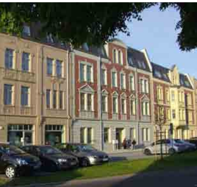
Das modernisierte Gebäudeensemble „Am Schäferberg“ in Staßfurt Quelle: Wohnungs- und Baugesellschaft mbH Staßfurt
