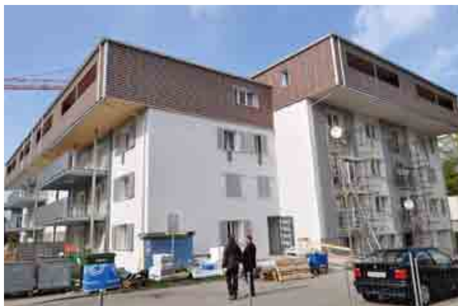
Pilotprojekt Ankengasse in der Nähe von Zürich: auf Minergie-Standard sanierter Altbau – mit einer aufgesetzten Neubau-Etage.
