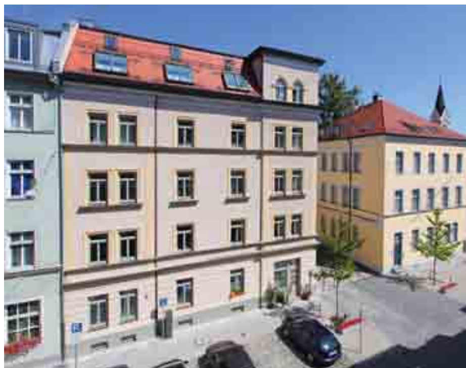
Eine Außendämmung kam aufgrund der Denkmalschutzauflagen nicht in Frage.
