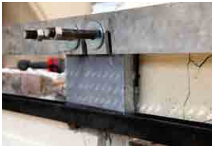
Detailansicht der Balkonanschlüsse für die Balkone im Monroe Park.
