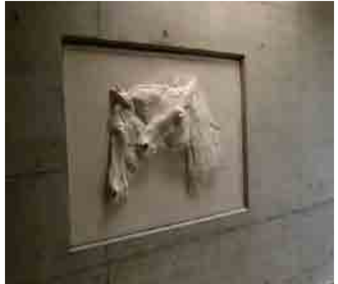
In den Treppenhäusern erinnern eingelassene Pferde- reliefs an die Historie des Standortes.
