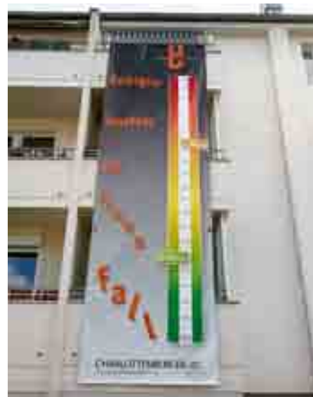
Warmmietenneutrale Modernisierung für die Mieter im Berliner Schwendyweg: Photovoltaik auf dem Dach und BHKW sind zu einem Kleinkraftwerk kombiniert und liefern günstigen Kiezstrom. Quelle: Berliner Energieagentur GmbH
