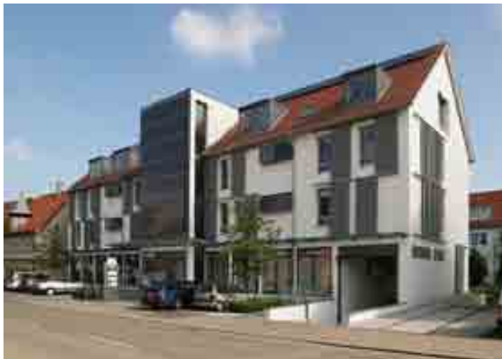
Verwaltungsgebäude der Kreisbaugenossenschaft Nürtingen eG mit Sitz in Kirchheim unter Teck.
