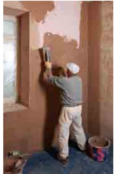
Mit der Dämmung der Flanke wird die Wärmebrückenproblematik minimiert. Das nicht brennbare Plattenmaterial wird mit dem im System enthaltenen Klebspachtel auf die Wand gebracht. Eine Dampfbremse wird nicht benötigt. Quelle: Knauf
