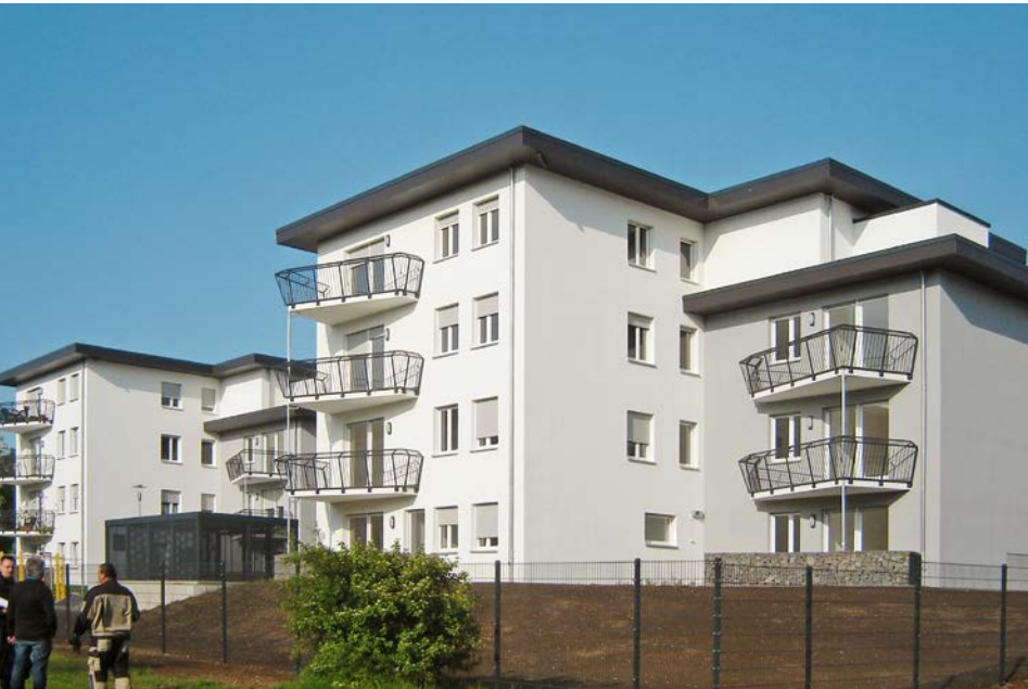
Der Verein zur Förderung der Nachhaltigkeit im Wohnungsbau hat auf dem „Tag der Wohnungswirtschaft“ des Branchendachverbandes GdW in Berlin der Wohnungsgesellschaft Hettstedt mbH für den nachhaltigen Neubau eines Mehrfamilienhauses ein NaWoh-Qualitätssiegel verliehen
