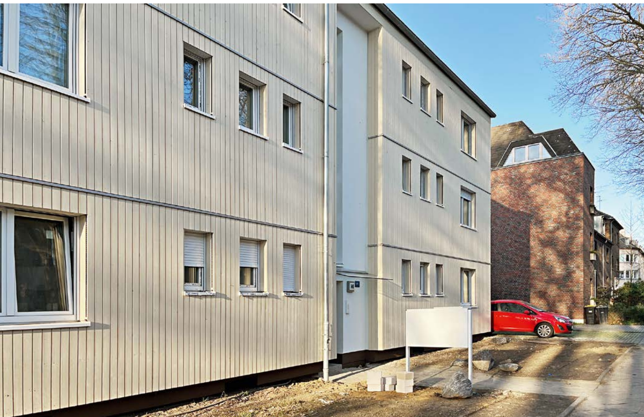
Das Pilotprojekt in der Zeppelinstraße in Mönchengladbach bietet nach der Montage der Fassadenelemente in Holzoptik ein ganz neues und ansprechendes Erscheinungsbild
