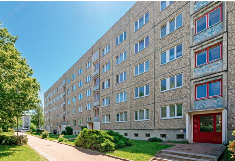
So sah der Plattenbau vor Beginn der Umbauarbeiten aus
