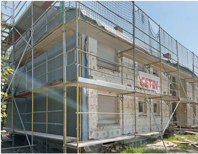
Besonders gut geeignet ist die Methode der seriellen Sanierung für kompakte Gebäude ohne Vorsprünge und Balkone
