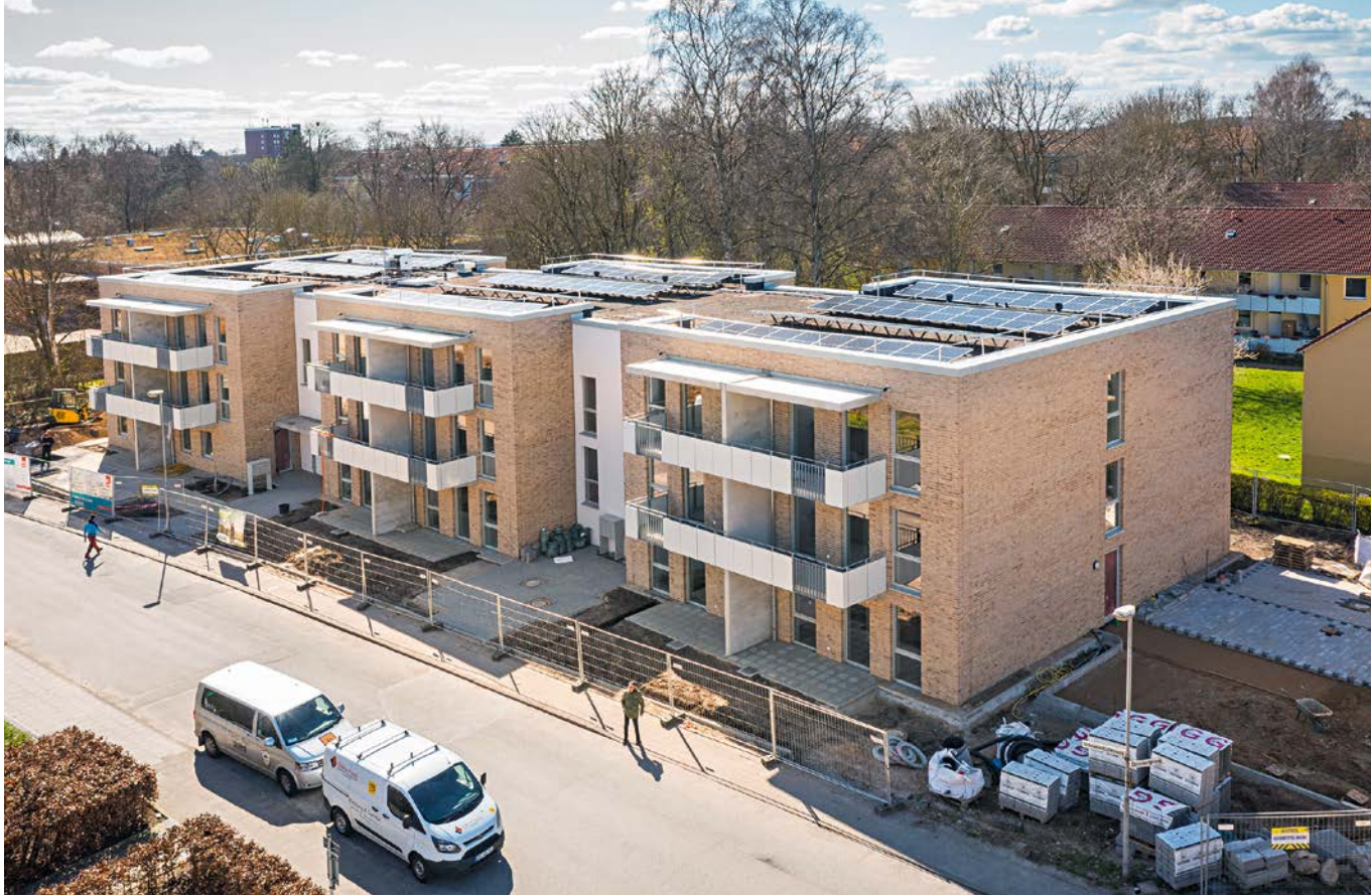
Auch für Bauvorbereitungskosten können Umbuchungen zum Umlaufvermögen vorgenommen werden. Neubau der Grundstücks-Gesellschaft Trave mbH im Schneewittchenweg 3+5 in Lübeck-Moisling. Hier entstehen 31 öffentlich geförderte Wohnungen und ein von einem sozialen Träger betreutes Büro für behinderte Menschen
