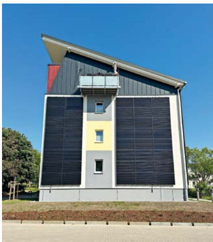
Auch die giebelseitige Fassade ist mit Photovoltaikmodulen bestückt
