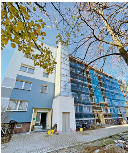
Bei Modernisierungen kann der Buchwert im Anlagevermögen geführt und abgeschrieben werden. Einbau eines Fahrstuhls in ein Gebäude der Wiwog in Lutherstadt Wittenberg
