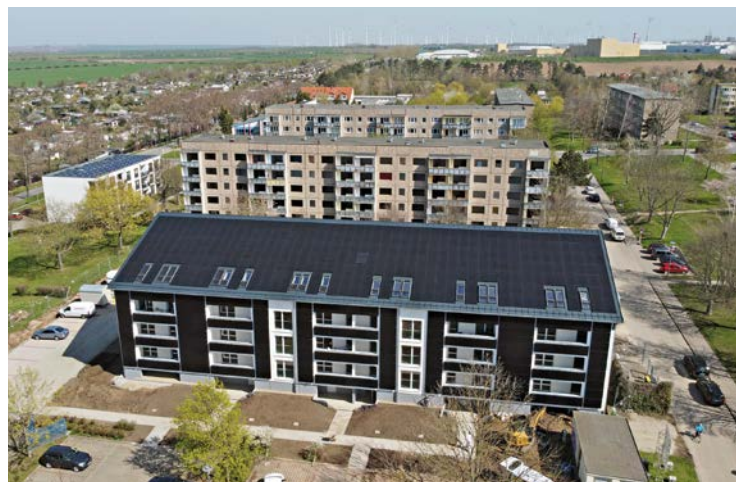
Die beiden Plattenbauten hinter dem bereits modernisierten Objekt sollen nach dem gleichen Konzept energetisch ertüchtigt werden
