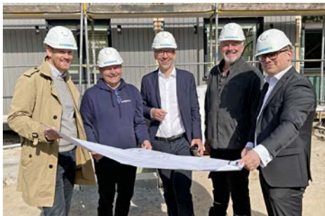
Die Verantwortlichen auf der Baustelle des jüngsten Renowate-Projekts Vossenbäumchen 2-8 in Mönchengladbach. Ganz rechts Andreas Miltz, Geschäftsführer der Renowate GmbH, in der Mitte Dr. Volker Wiegel, COO der LEG Immobilien SE
