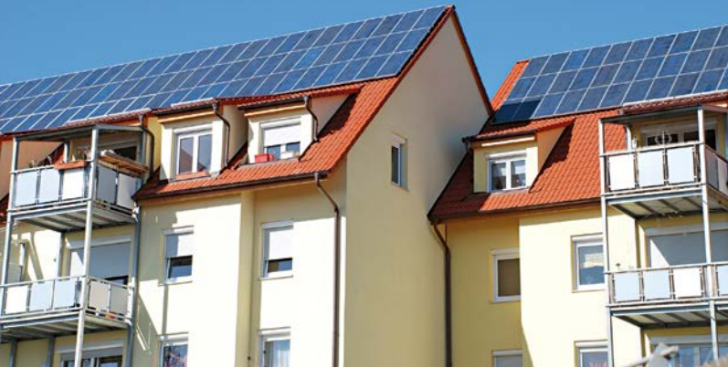
Auch Nebenleistungen zur Lieferung und Installation von PV-Anlagen sind begünstigt
