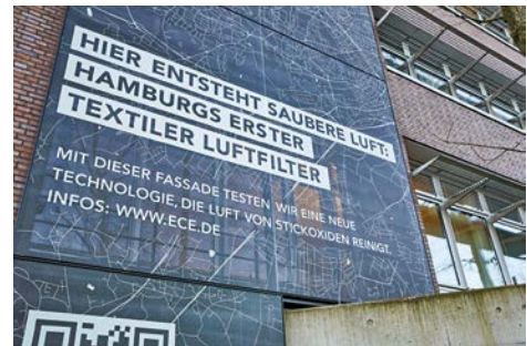
Die Textilfassade beim Hamburger Unternehmen ECE senkt durch eine spezielle Beschichtung die Feinstaubbelastung
