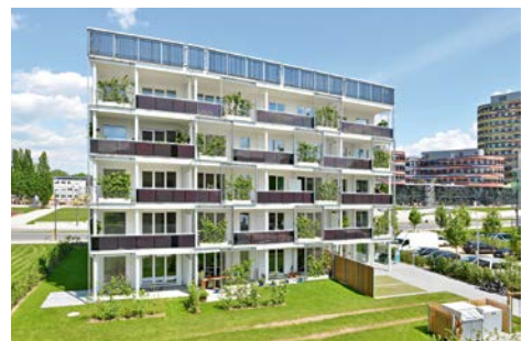
Das Wohngebäude „Smart ist grün“ sorgte bei der IBA für Aufsehen: Die „energieintelligente Fassade“ kann Energie erzeugen und speichern
