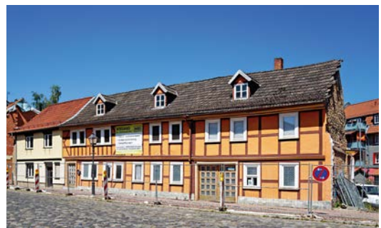
Die Häuser Am Alten Tor 2-3 vor der grundlegenden Sanierung
