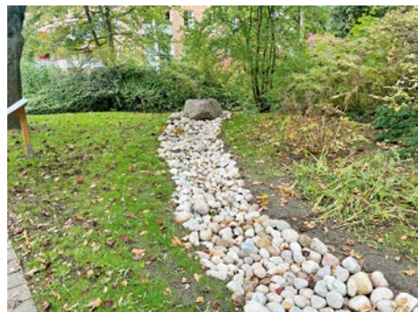
Regenwasser-Retentionsfläche im Quartier Heidrehmen in Hamburg-Iserbrook
