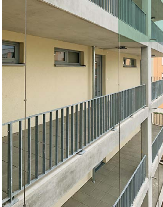
Um das Gebäude nachträglich zu begrünen, entschied man sich für eine Variante mittels Seilsystem
