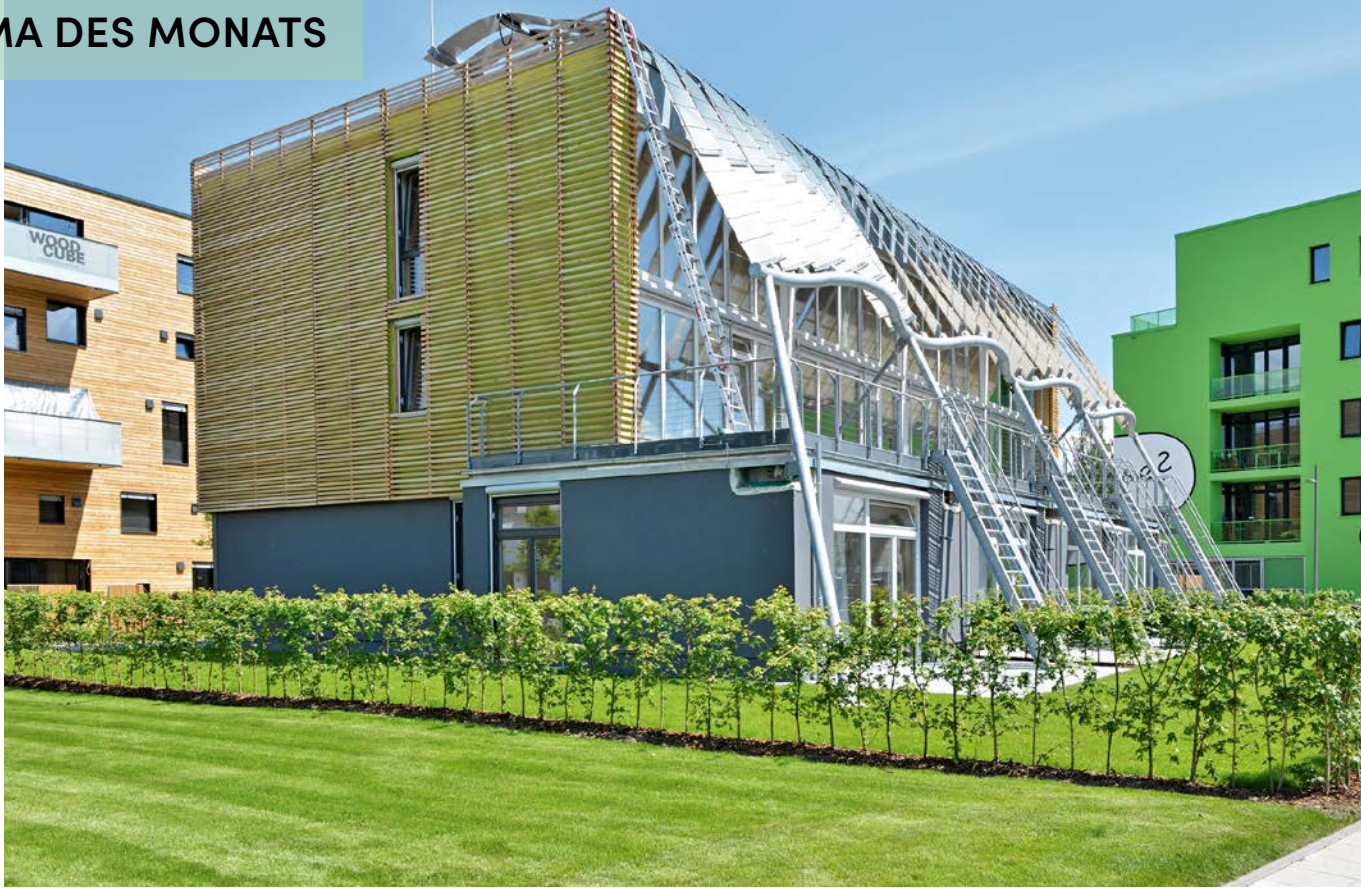
„Soft House“ der IBA Hamburg: Die textile Membranfassade an der Südseite reagiert flexibel auf Sonneneinstrahlung. In die Membran eingearbeitete PV-Zellen können so das Sonnenlicht optimal zur Energieproduktion nutzen
