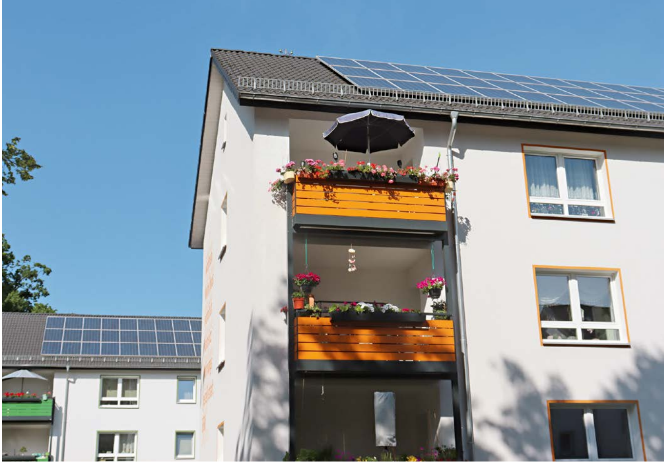
Unter bestimmten Voraussetzungen unterliegen Lieferung und Installation von PV-Anlagen seit dem 1. Januar 2023 dem Nullsteuersatz. Begünstigt sind PV-Anlagen auf oder in der Nähe von Wohngebäuden
