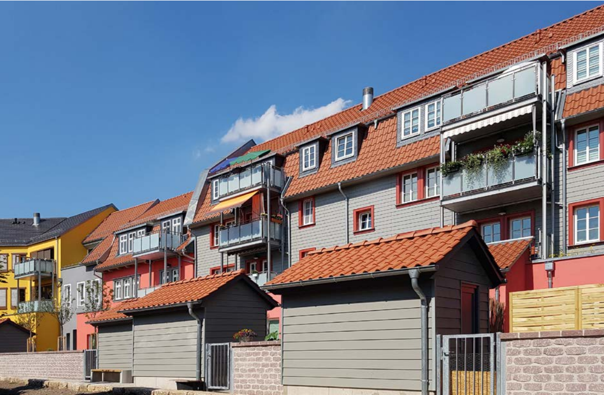
In der Schärfgasse sind den Erdgeschosswohnungen Mietergärten zugeordnet. Auch Schuppen für Gartengeräte fehlen nicht
