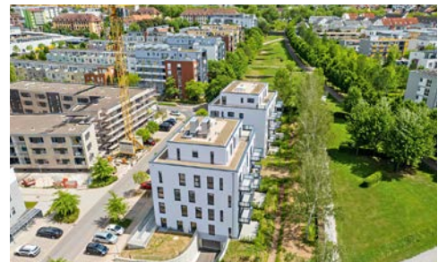
Die „Spessart-Gärten“ in Aschaffenburg sind Teil der Konversionsliegenschaft „Travis Park.“ Aus dem ehemaligen Militärgelände wird nun ein Wohngebiet
