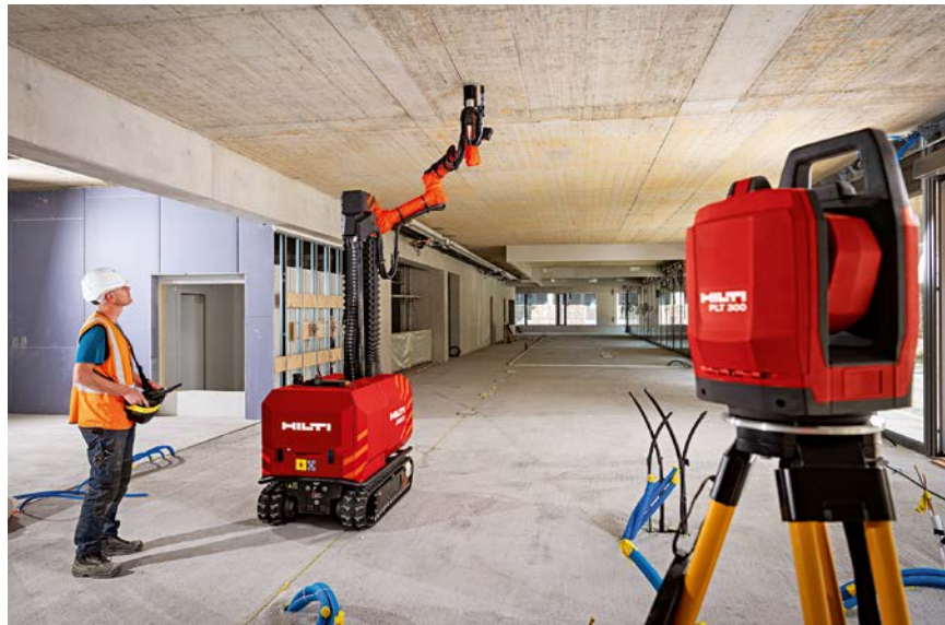
Ein Beispiel für einen semi-autonomen Baustellenroboter ist der „Jaibot“, der sich per Fernsteuerung über die Baustelle navigieren lässt
