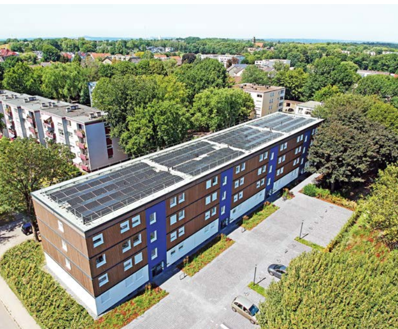
Das erste Energiesprong-Projekt im Ruhrgebiet wurde im April 2022 fertiggestellt. 32 Wohneinheiten sparen seitdem jährlich 92 t CO 2 ein
