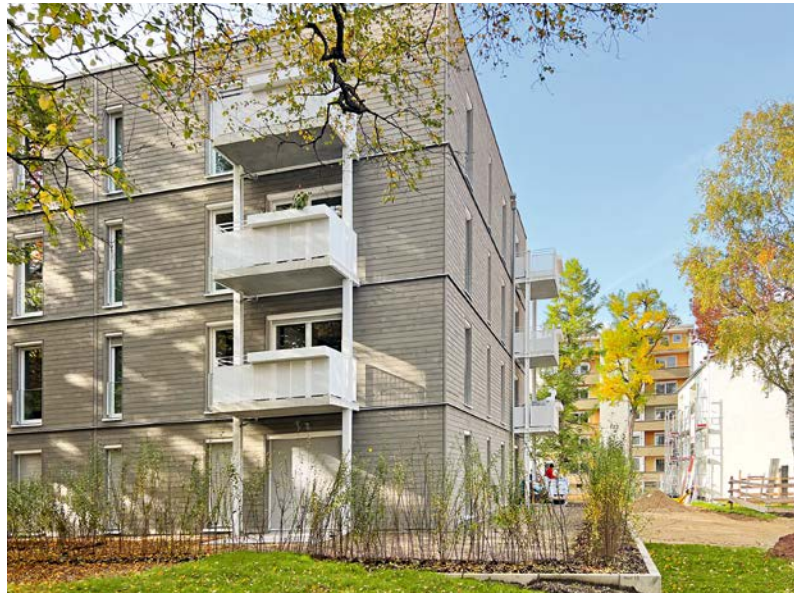
Die zwei Holzhybridhäuser mit 19 Wohneinheiten an der Reinerzer Straße in Nürnberg waren im Jahr 2022 bezugsfertig. Fünf weitere Gebäude sind in Planung
