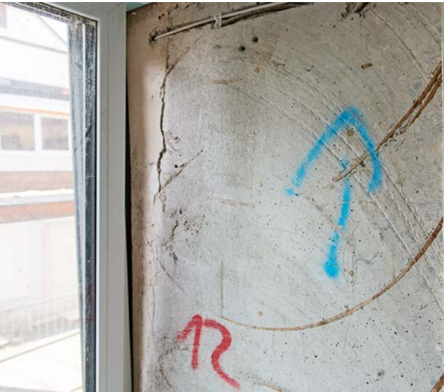
Auch innen bleiben die 1,10 m starken Betonwände sichtbar
