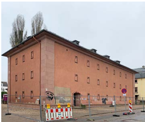
Vor dem Umbau war die alte Funktion des im Heimatschutzstil gehaltenen Weltkriegsbunkers noch ersichtlich
