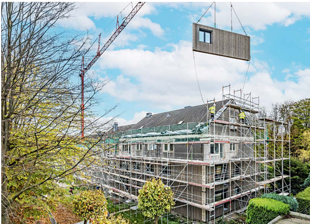
Vorproduzierte Fassadenelemente bilden die neue Außenhaut und ermöglichen Net-Zero-Standard des Gebäudes. Das heißt, es erzeugt soviel Energie wie die Mieter für Haushaltsstrom und Wärme verbrauchen
