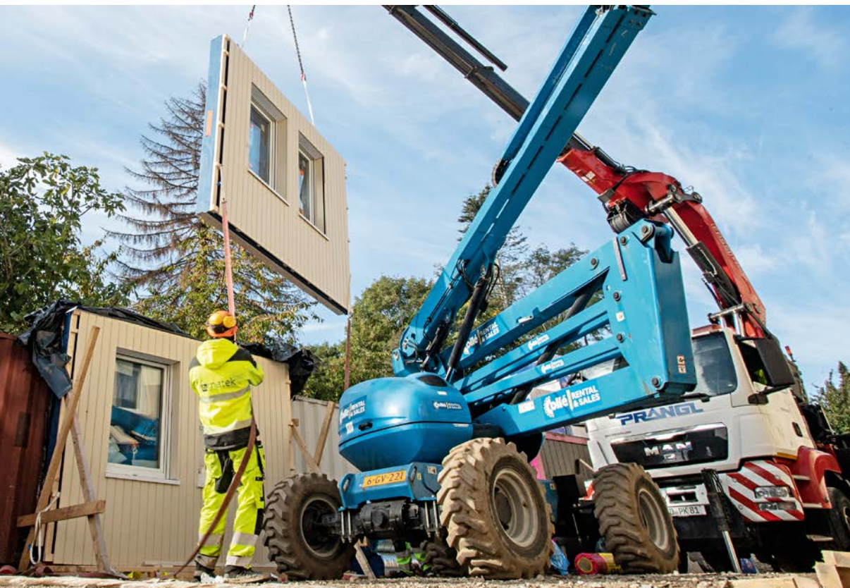
„Fliegende“ Fassadenelemente kurz vor der Montage an den Gebäuden
