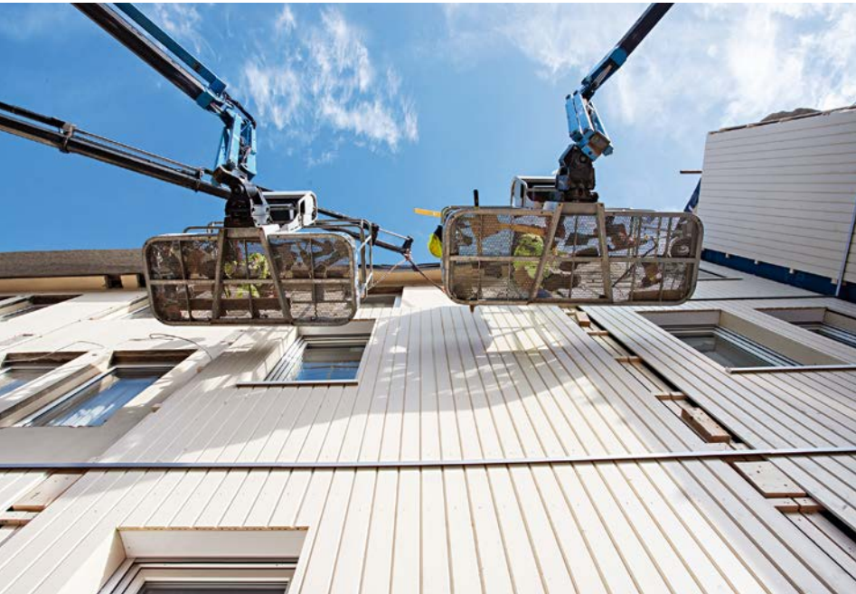
Die vorgefertigten Fassadenteile werden direkt am Bestandsgebäude befestigt
