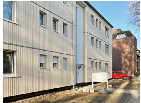
Das Pilotprojekt in der Zeppelinstraße in Mönchengladbach bietet nach der Montage der Fassadenelemente in Holzoptik ein ganz neues und ansprechendes Erscheinungsbild
