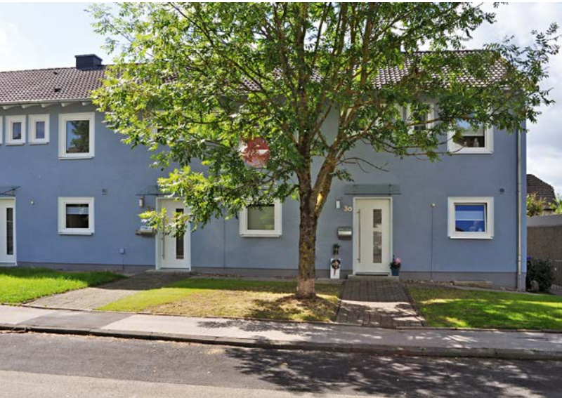
Bei den sanierten Reihenhäusern in der Detmolder Britensiedlung betrug die Anfangsmiete 6,30 €/m 2
