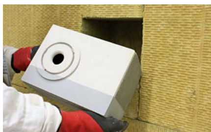
Artenschutz und moderne Fassadendämmung zugleich werden mit den leicht zu montierenden Nistkasten-Elementen möglich
