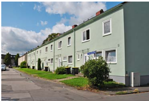
In der Britensiedlung in Detmold hat die eigens für das Projekt gegründete Kommunale Wohnungsgenossenschaft 44 Reihen- und Doppelhäuser saniert
