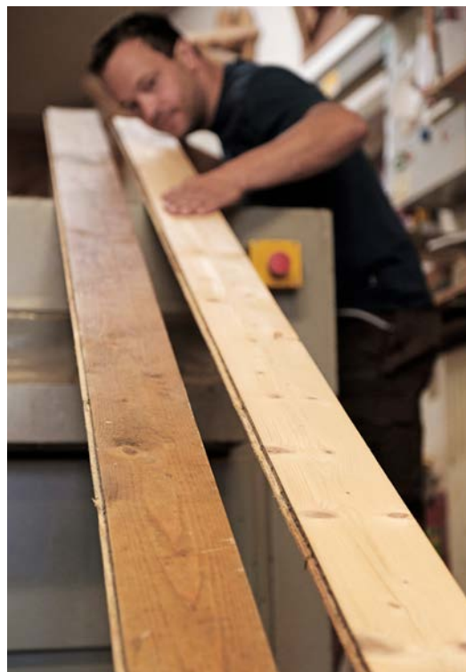
Urban Mining: Holzdielen aus einem Rückbauobjekt wurden für die Garagenaufstockungen aufbereitet
