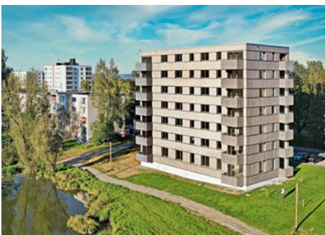
Bei diesem 21 m hohen Vollholzbau der Sozialbau Kempten mit 21 Wohnungen wurden die tragenden Brettstichholz-Bauteile für Wände und Decken aus rund 350 heimischen Fichten gewonnen
