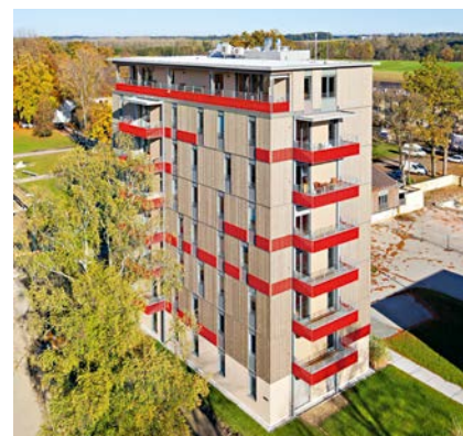
Holzbaupionierleistung: Das 2011 auf dem B&O-Parkgelände in Bad Aibling erreichte „Holz8“ setzte Maßstäbe für das Bauen mit Holz an der Hochhausgrenze
