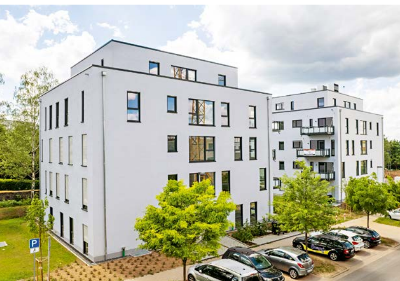
Die bodentiefen Fenster folgen der flexiblen Organisation im Modulbau und müssen nicht – wie bei massiven Bauweisen – aus statischen Gründen streng übereinander positioniert werden
