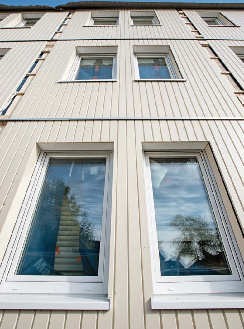
Die vorgefertigten Fassadenelemente sind komplett ausgestattet, so unter anderem auch mit Fenstern und einer Lüftungsanlage
