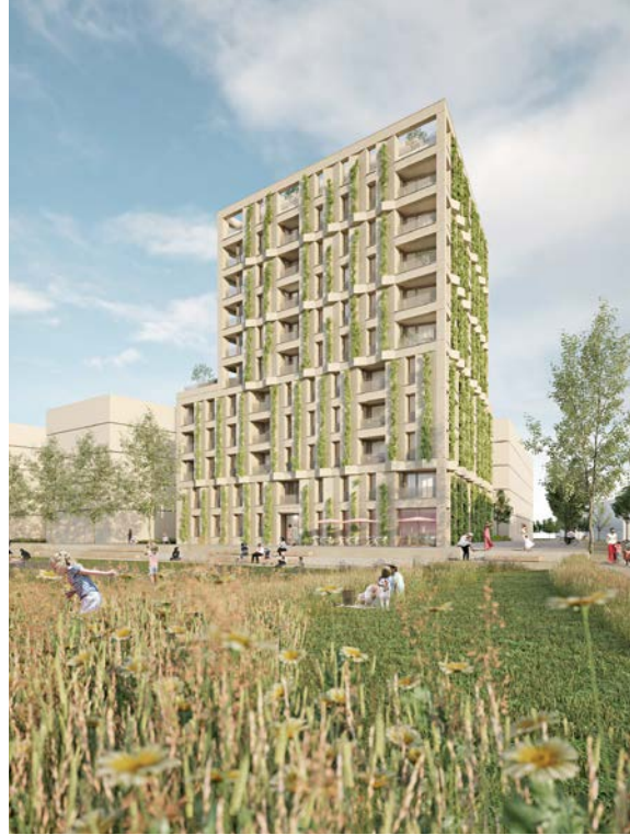
Der „Hochpunkt Spinelli“ – ein 10-Geschosser der Flüwo Bauen Wohnen eG – in Mannheim beeindruckt auch durch seine Fassadenbegrünung
