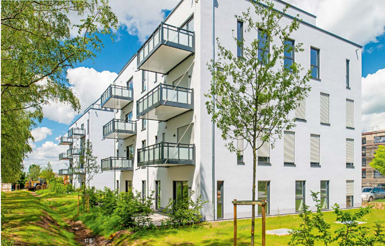
Die geräumigen Balkone wurden nicht als separate Tragkonstruktion dem Baukörper vorangestellt, sondern an einer Stahlkonstruktion der Fassade freitragend angehängt. Sie brauchen keine mächtigen Stützen und wirken dadurch filigran
