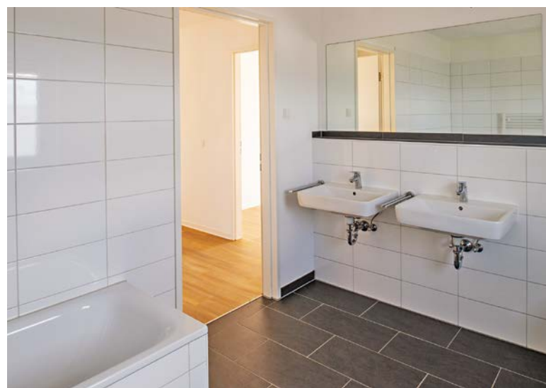
In den WCs und Bädern sorgen bodengleiche Duschen, breite Türen mit schwellenlosen Übergängen sowie ausreichend Bewegungsfläche für Barrierefreiheit
