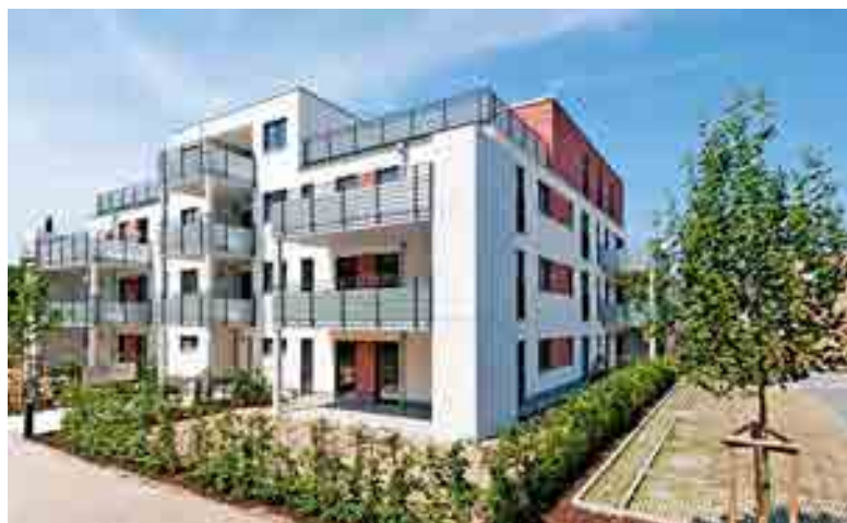
Neubauprojekt Horlache Park der gewobau Rüsselsheim in der Moritz von Schwindstraße
