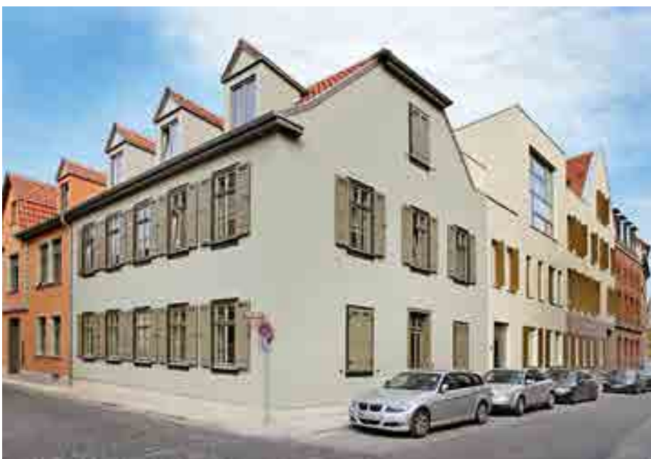
Das Erfurter Bauensemble Schottenhöfe - hier die Straßenansicht - stellt ein innerstädtisches Entwicklungsprojekt dar, bei dem in vorbildlicher Weise alt und neu verbunden wurde
