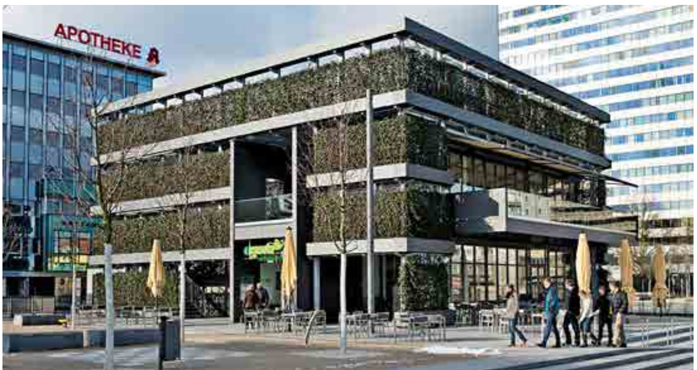
Agora (Restaurant): Gewerbeimmobilie der BGW, die im Jahr 2014 mit einer Grünfassade errichtet wurde
