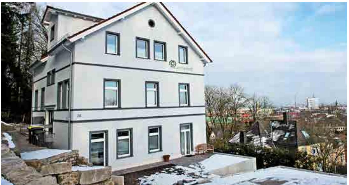
Ein aus dem Jahr 1865 stammender, komplett sanierter Altbau der BGW in Bielefeld mit drei Wohnungen
