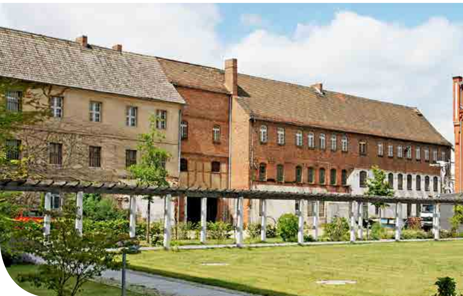
So war das Bild vor Beginn der Bauarbeiten. Der linke Gefängnistrakt wird jetzt zu einem Wohngebäude umgebaut, während im Gebäudeteil in der Mitte des Bildes bereits zehn Wohnungen entstanden sind
