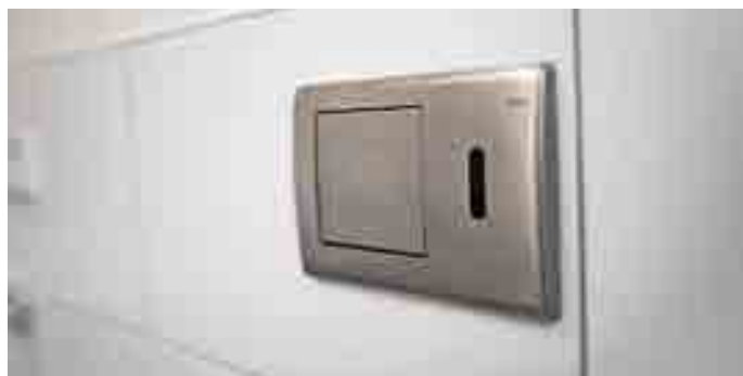
Die Edelstahl-Betätigungsplatte verfügt über einen integrierten Infrarotsensor, der berührungslos zu bedienen ist
