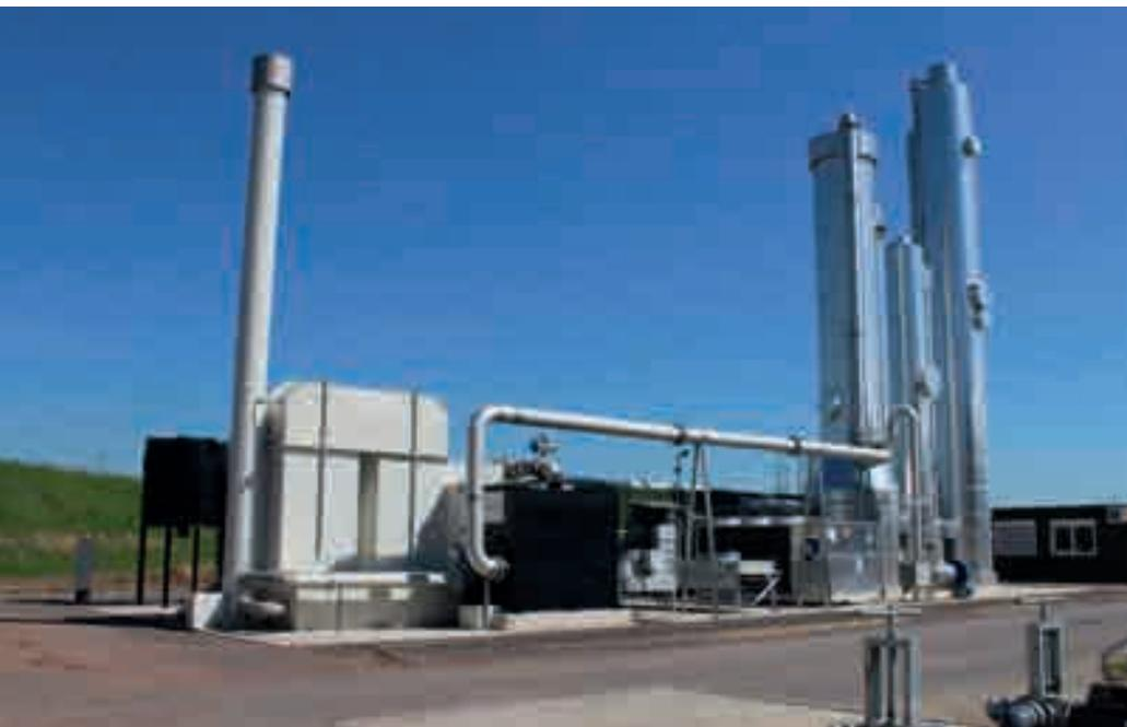
Anlage zur Aufbereitung von Biogas
