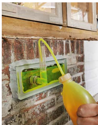
Bild 1: Eine sogenannte Franke-Platte oder WA-Prüfplatte im Einsatz bei der Messung der „Schlagregendichtigkeit“
