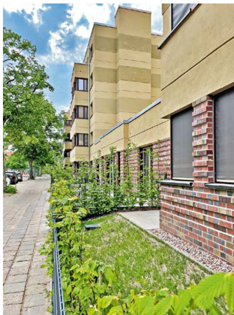
In diesen Gebäuden in Berlin-Pankow arbeitet eine Grauwasser-Nutzungsanlage
