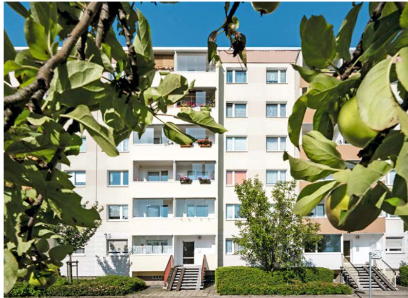
Digitale Gebäudetechnik smart integriert: Vorzeigebauwerk der energetischen Optimierung im Gebäudebestand der Bauverein Halle & Leuna eG ist dieses sechsstöckige Mehrfamilienhaus mit 109 Wohnungen in Halle-Neustadt
