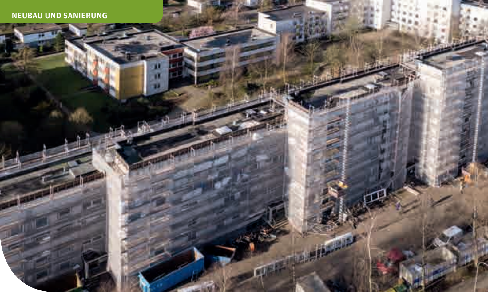
Das Adlershorst-Quartier Waldstraße in Norderstedt – derzeit sind die Modernisierungsarbeiten im vollen Gange. Hier wird ein innovatives Modell des Belegungsankaufs im Bestand praktiziert, das dem stetigen Auslaufen von Sozialbindungen entgegen wirkt
