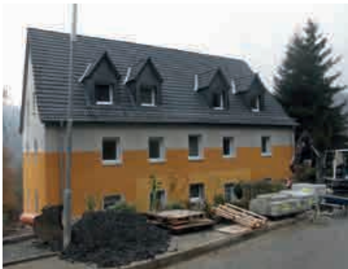
Eines der sanierten Gebäude in Altena-Breitenhagen
