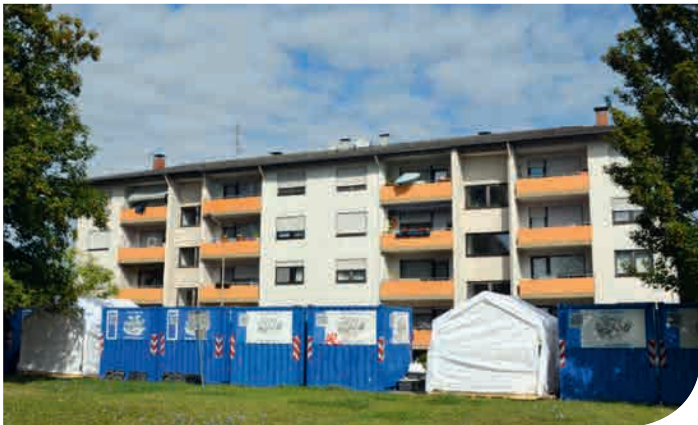
Die Container mit allen Badbestandteilen vor dem Mehrfamilienhaus im rheinland-pfälzischen Budenheim
