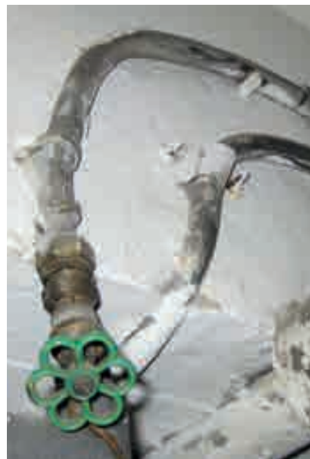
Bleirohre lassen sich aufgrund ihrer Biegsamkeit in Bögen verlegen
