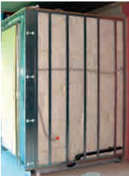
Situation im Rohbau: Alle Leichtbau-Fertigbäder wurden komplett eingerichtet angeliefert
