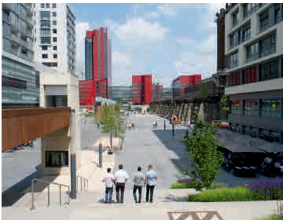
Begegnung ermöglichen und fördern: öffentliche Plätze und Freiräume im urbanen Kontext
