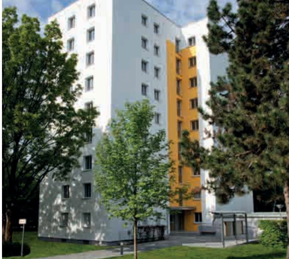
Das Punkthaus in der Untermezzinger Straße 80 nach der Sanierung
