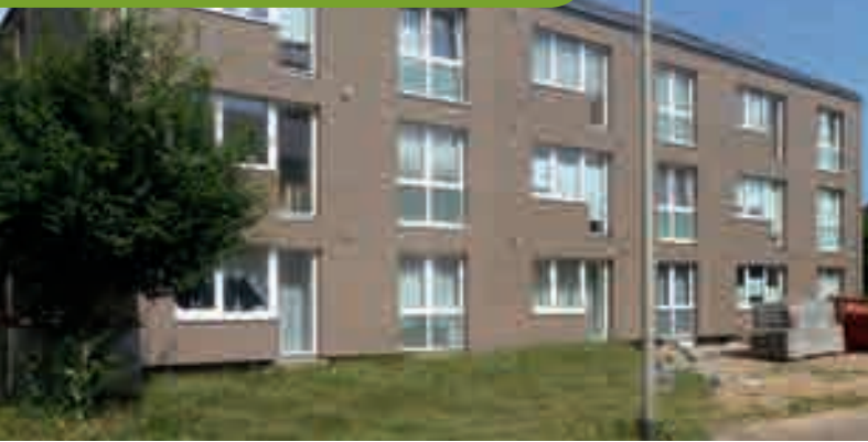
Die guten Energiewerte und das optische Erscheinungsbild überzeugt Bauherren und Nutzer
