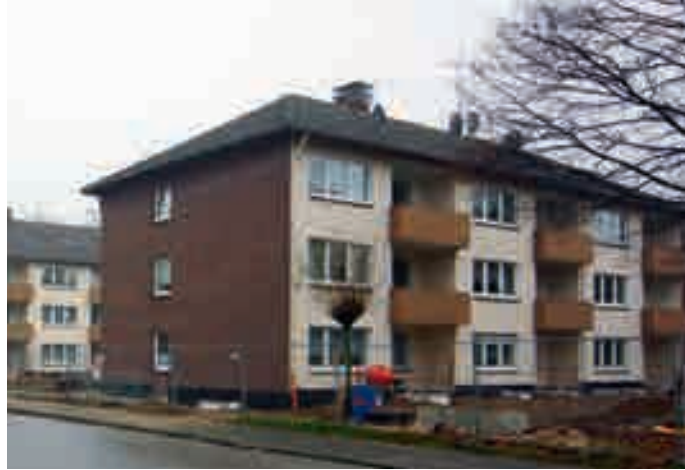
Ansicht der beiden baugleichen Gebäude aus dem Baujahr 1967 vor der Sanierung
