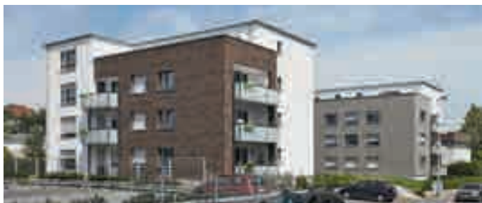
Die Häuser nach der Sanierung
