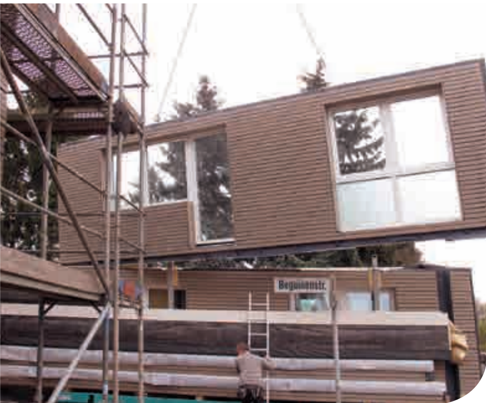
Anlieferung der Fassadenelemente
