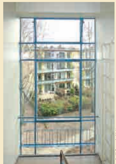
Treppenhausfenster und Treppenaufgänge konnten bauzeitlich ausgeführt werden
