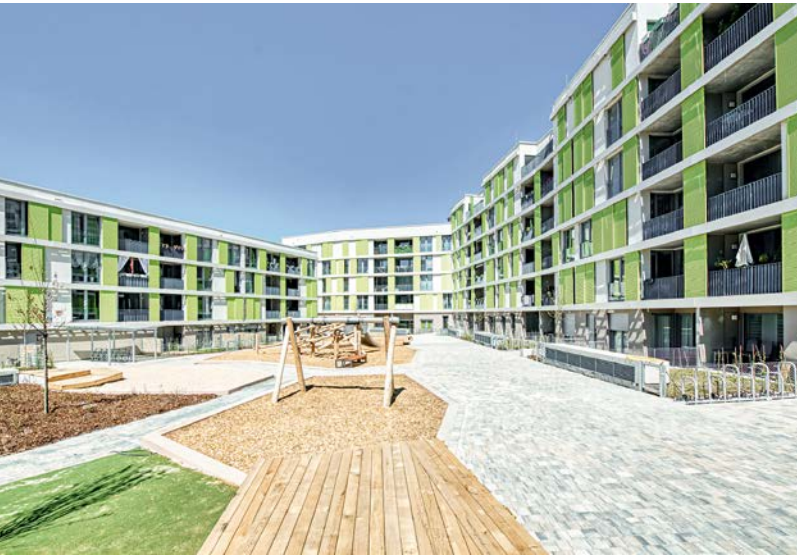
Wohnanlage der WBG Nürnberg in der Nürnberger Südstadt: das Projekt European 12 erweitert eine Wohnanlage aus den 1920er Jahren
