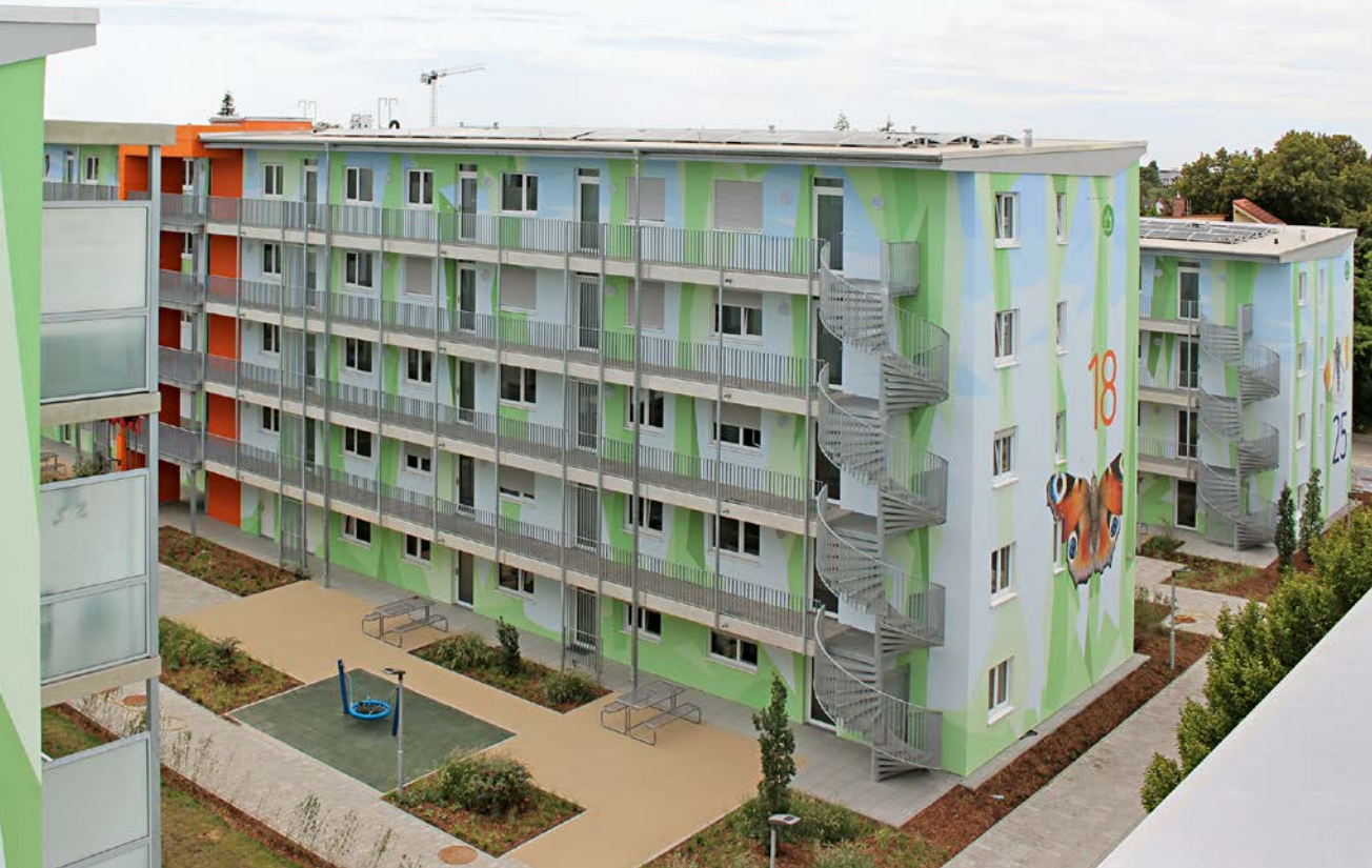
Erfolgreiches Mieterstrommodell: Auf jedem der acht Wohnhäuser der Anna-Sofien-Höfe befindet sich eine Photovoltaikanlage
