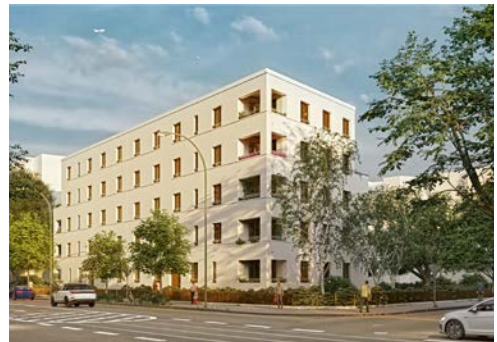
Im November 2022 begann die Wohnungsbau-gesellschaft Berlin-Mitte mbH mit dem Bau von 26 Mietwohnungen in Berlin-Niederschönhausen. Manche Wohnungsunternehmen stellen Neubau-projekte wegen der veränderten Finanzierungsbedingungen sogar zurück
