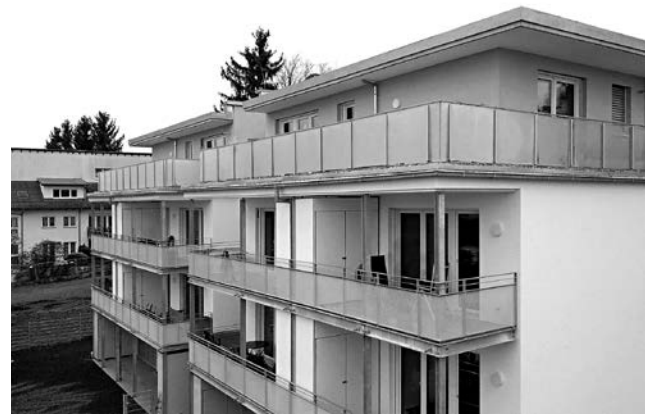
Ohne Zusatzgeräte können die Bewohner des Hegau-Neubaus in Radolfzell TV und Radio via Satellit über das Glasfasernetz empfangen. Drei kleine „Schüsseln“ auf dem Dach versorgen hier 50 Wohnungen
