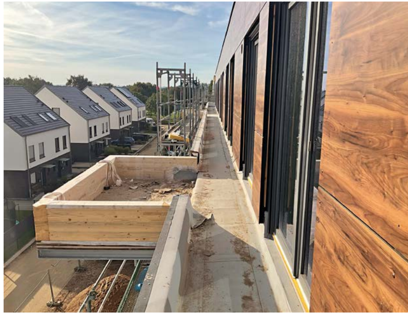
Die Staffelgeschosse entstanden komplett aus vorgefertigten Holzmodulen. Das neu erschlossene Areal umfasst auch Doppelhäuser, die durch die Mehrfamilienhäuser vom Bahnlärm abgeschirmt sind
