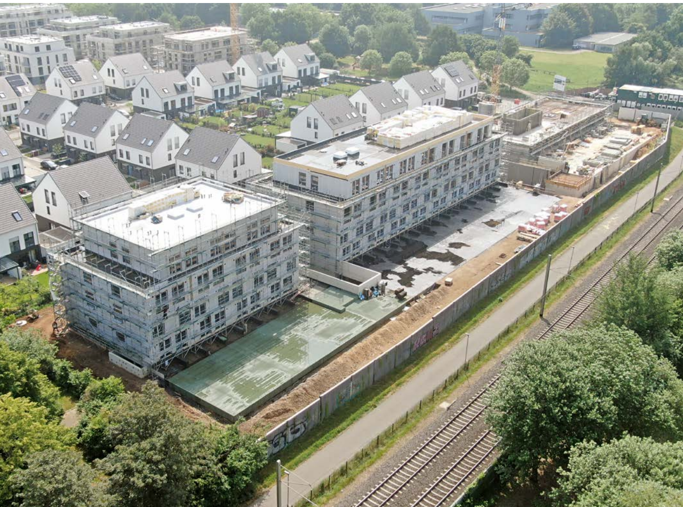
Die drei Gebäude reihen sich entlang der Bahnlinie Köln-Bonn. Links der Teil mit kleineren Wohnungen. An der Lärmschutzwand wurden zusätzliche PV-Module installiert, für die auf dem Dach nicht genügend Platz war
