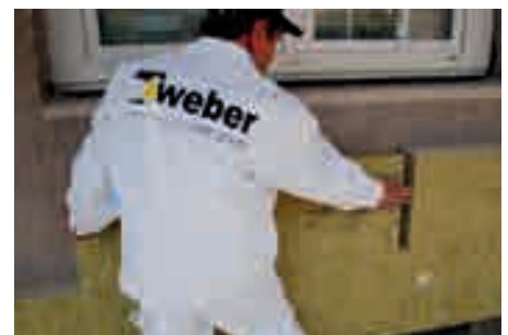
Im Rahmen der Sanierungsarbeiten wurde ein vollmineralisches WDVS verwendet
