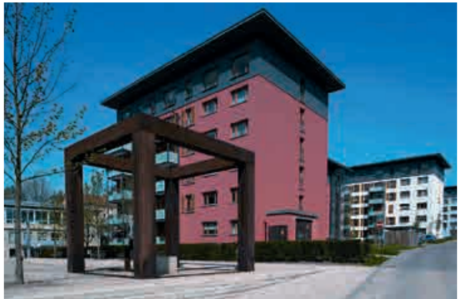
Dämmfassaden, wie sie überall in Deutschland zu finden sind
