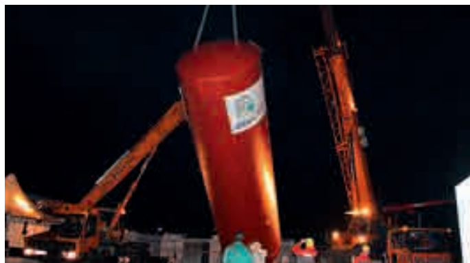
Anfang Dezember 2013 wurde der Solarspeicher aufgestellt
