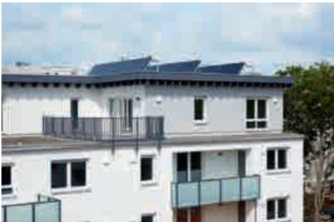
Zehn neue Wohneinheiten entstanden allein durch die Aufstockung der 1960 errichteten Häuser. Aus statischen Gründen wurden die aufgesetzten Geschosse in Leichtbauweise gebaut
