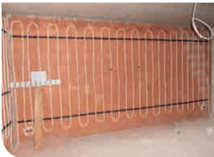
Funktionsprinzip einer Wandheizung. Besonders wichtig ist die genaue Einhaltung des Verlegeplans
