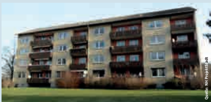
Noch unsanierter Bestand der Nassauische Heimstätte/Wohnstadt in Fulda-Zieher
