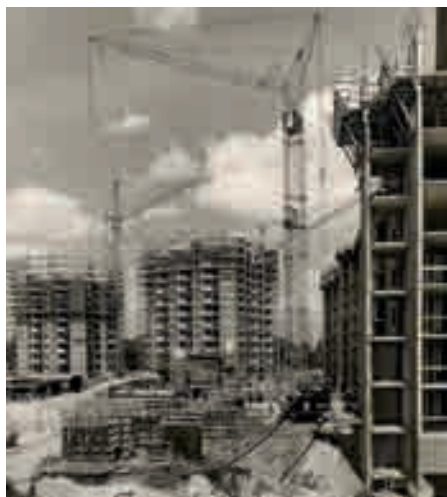
Blick auf die Wohngebäude „Jorinde“, „Joringel“ und „Lindwurm“ von Prof. Rolf Gutbrod im degewo-Gebiet der Gropiusstadt, um 1968
