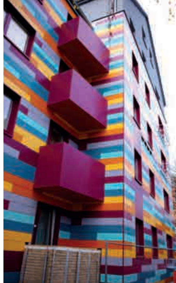
Die Fassade heute: Die Balkonverkleidungen wurden farblich aus der Fassadengestaltung aufgenommen
