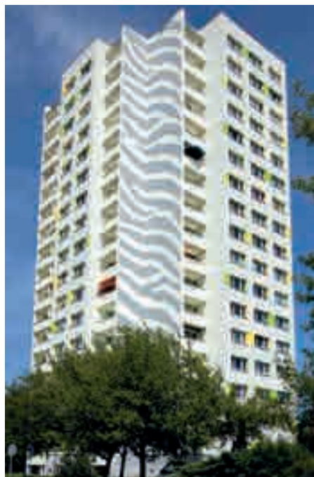
Sanierte und farbenfroh gestaltete Punkthochhäuser der kommunalen Wohnungsgesellschaft Erfurt...
