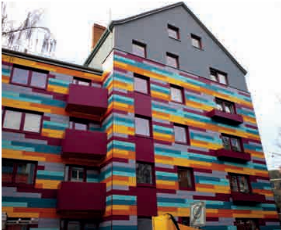
Gestaltung, Planung und Verarbeitung sind die Erfolgsfaktoren einer Fassadensanierung
