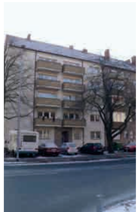
Tristess vor der Sanierung: Ein einheitliches Grau in Grau
