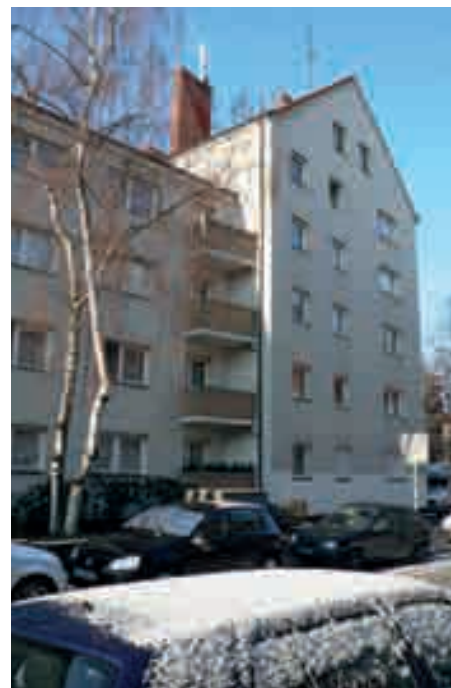
Früher: Die Fassade, wie sie nach der 1. Sanierung in den 1980er Jahren aussah
