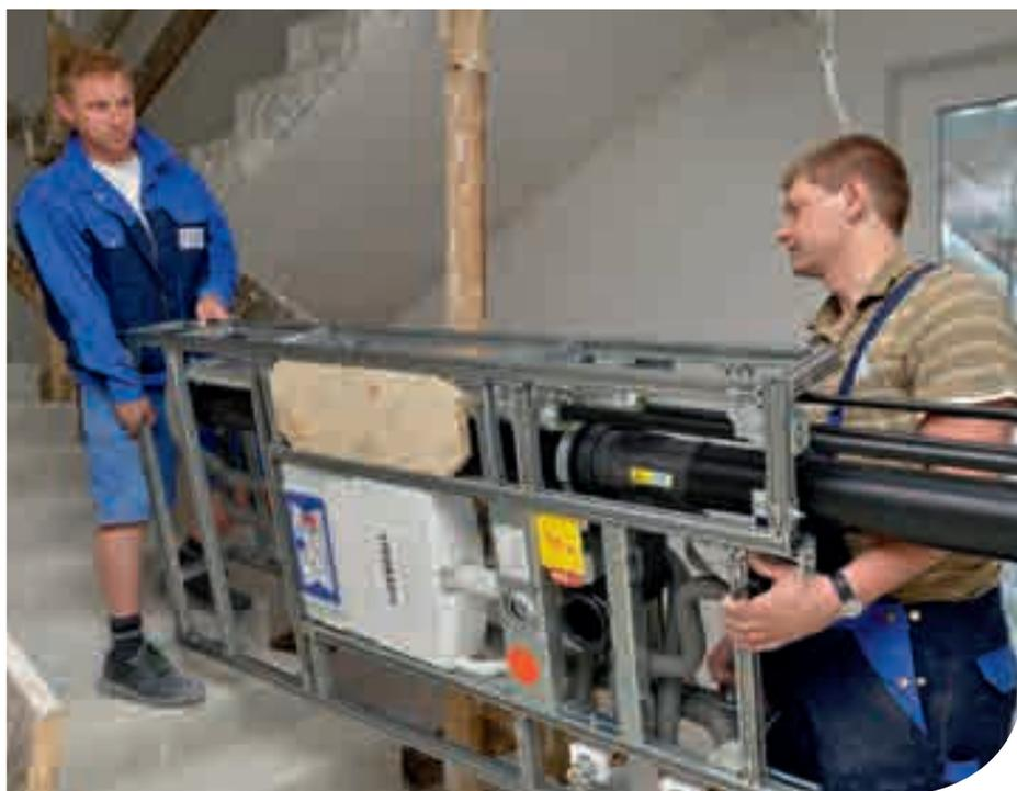
Just-in-time-Prinzip: der Hersteller liefert die anschlussfertigen Register am Einbautag direkt auf die Baustelle. Monteure tragen die Wände zum Einbauort
