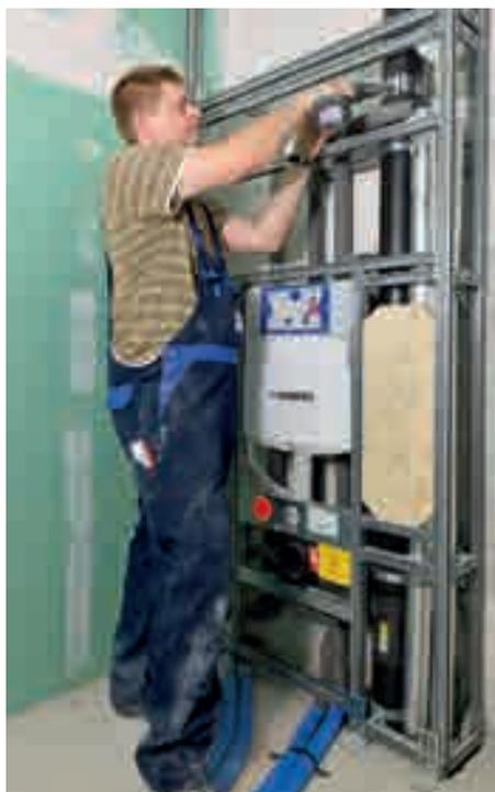
Optimiert für die Ein-Mann-Montage: Dank ausgeklügelter Technik genügt ein Installateur, um die Register mit der Wand zu verankern
