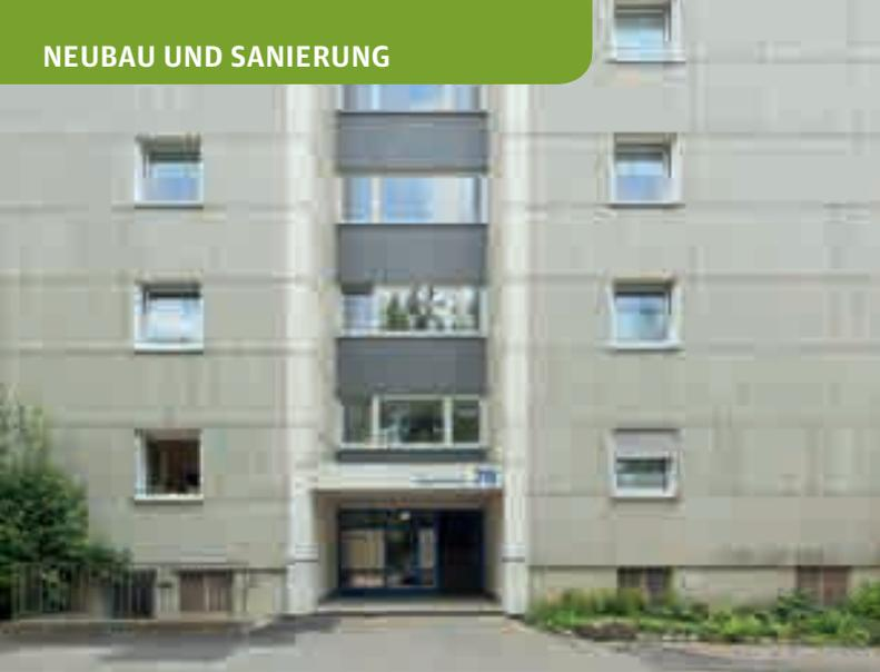
Zeichen der Zeit an der Fassade: die Witterung hat ihr zugesetzt, erste Feuchteschäden zeigten sich, die Asbestplatten mussten erneuert werden
