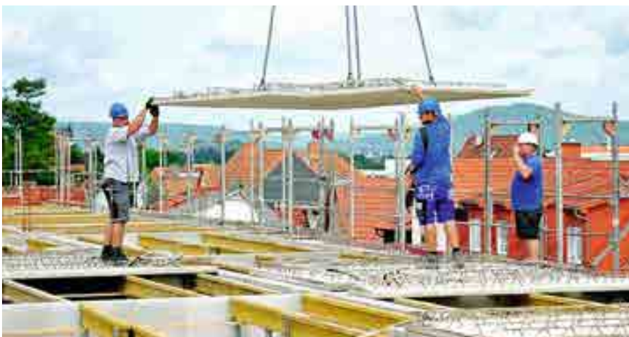
Just in time wurden die 55 Fertigelemente pro Geschossdecke angeliefert
