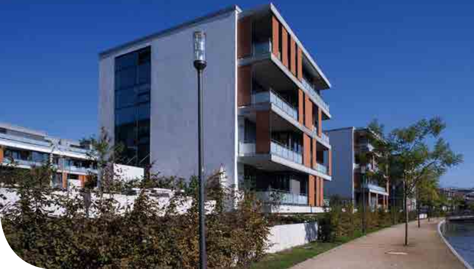
Eine Loggien-Zone mit verschiebbaren Sichtblenden bildet eine variable Pufferschicht zwischen dem öffentlichen und privaten Raum
