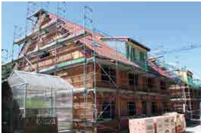
Eines der Mehrfamilienhäuser im Rohbau
