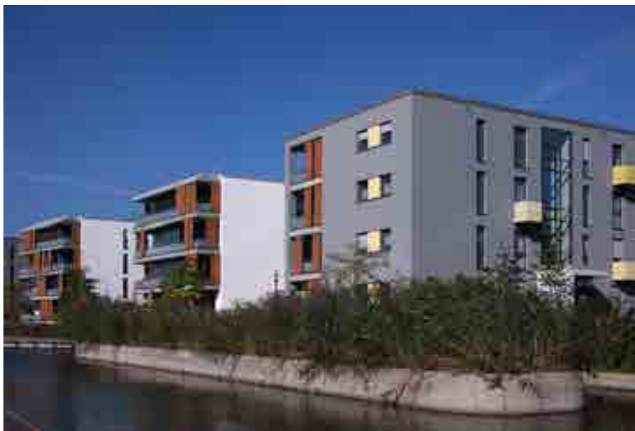
Die Wasserfläche vor dem Projekt Pier 78 im Universitätsviertel in Essen schafft Ruhe und Weite in der urbanen Wohnanlage
