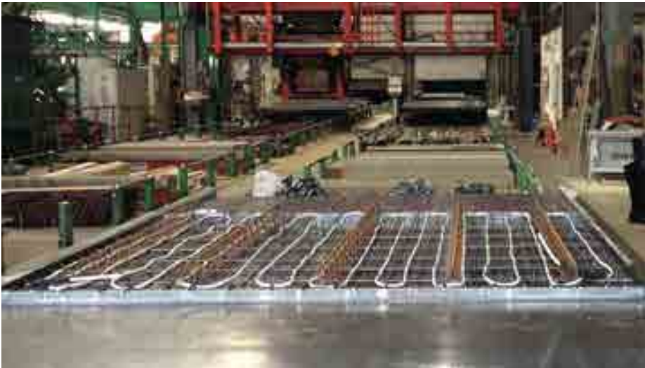
Nach dem Verlegeplan wurden die thermisch aktivierten Deckenelemente mit Rohrregistern bestückt
