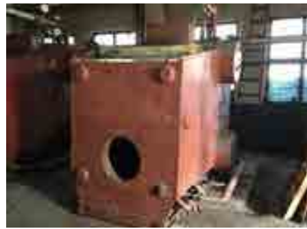
Einer von zwei Gasheizkesseln (l.) im Heizhaus des Modellgebietes (Baujahr 1966). Der Wirkungsgrad des Gas-kessels wird von der Stadt noch mit 78% angegeben! Hier steht auch ein selbstgebauter Holzheizkessel (r.), mit dem die Stadt Zhovkva versucht, das limitierte Gasangebot zu kompensieren. Fotos im Juli 2013
