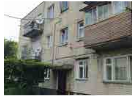
Typische Ziegelfassade eines Wohnhauses (Baujahr 1976) im Modellgebiet, das seither nicht saniert wurde; Foto aus dem Juli 2013
