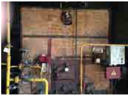
Einer von zwei Gasheizkesseln (l.) im Heizhaus des Modellgebietes (Baujahr 1966). Der Wirkungsgrad des Gas-kessels wird von der Stadt noch mit 78% angegeben! Hier steht auch ein selbstgebauter Holzheizkessel (r.), mit dem die Stadt Zhovkva versucht, das limitierte Gasangebot zu kompensieren. Fotos im Juli 2013
