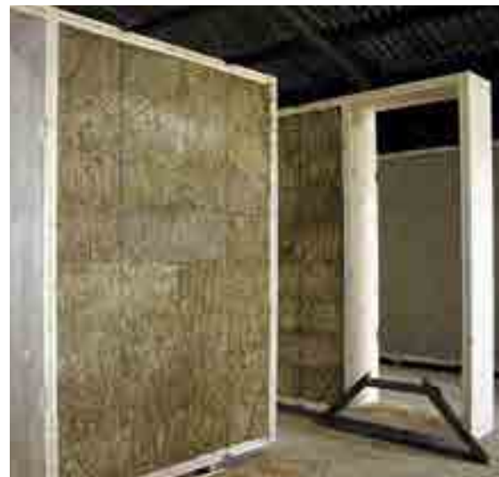
Für den Bau wurden vorgefertigte Holzrahmen mit einer Strohdämmung verwendet
