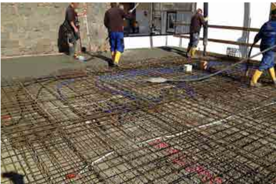
Die Fertigelemente wurden mit 12 cm Ortbeton aufbetoniert. Diese enthalten neben den Heizregistern auch Teile der Elektroinstallation
