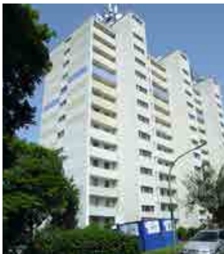
Die Bäder in diesem Hochhaus in der Niedernhofstraße in Hagen wurden im Mai modernisiert
