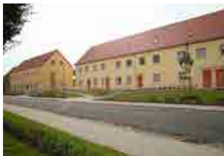
Nach der Modernisierung: Rampen ermöglichen den separaten Zugang zu den barrierefreien Wohnungen im Erdgeschoss
