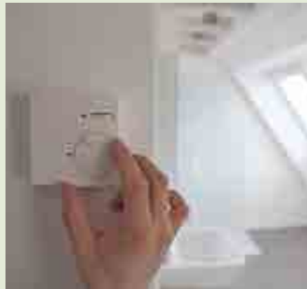
Ausreichende Frischluftzufuhr ist wichtig, um das Risiko der Schimmelpilzbildung sowie die Belastung durch Schadstoffe zu verringern. Mit automatischen Dachfenstern, gesteuert von einer Luftqualitätssteuerung (oben), wird über Sensortechnik bedarfsgerecht gelüftet
