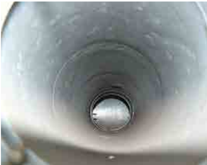
Zuluftrrohr mit regelmäßigem Filterwechsel nach 25 Jahren
