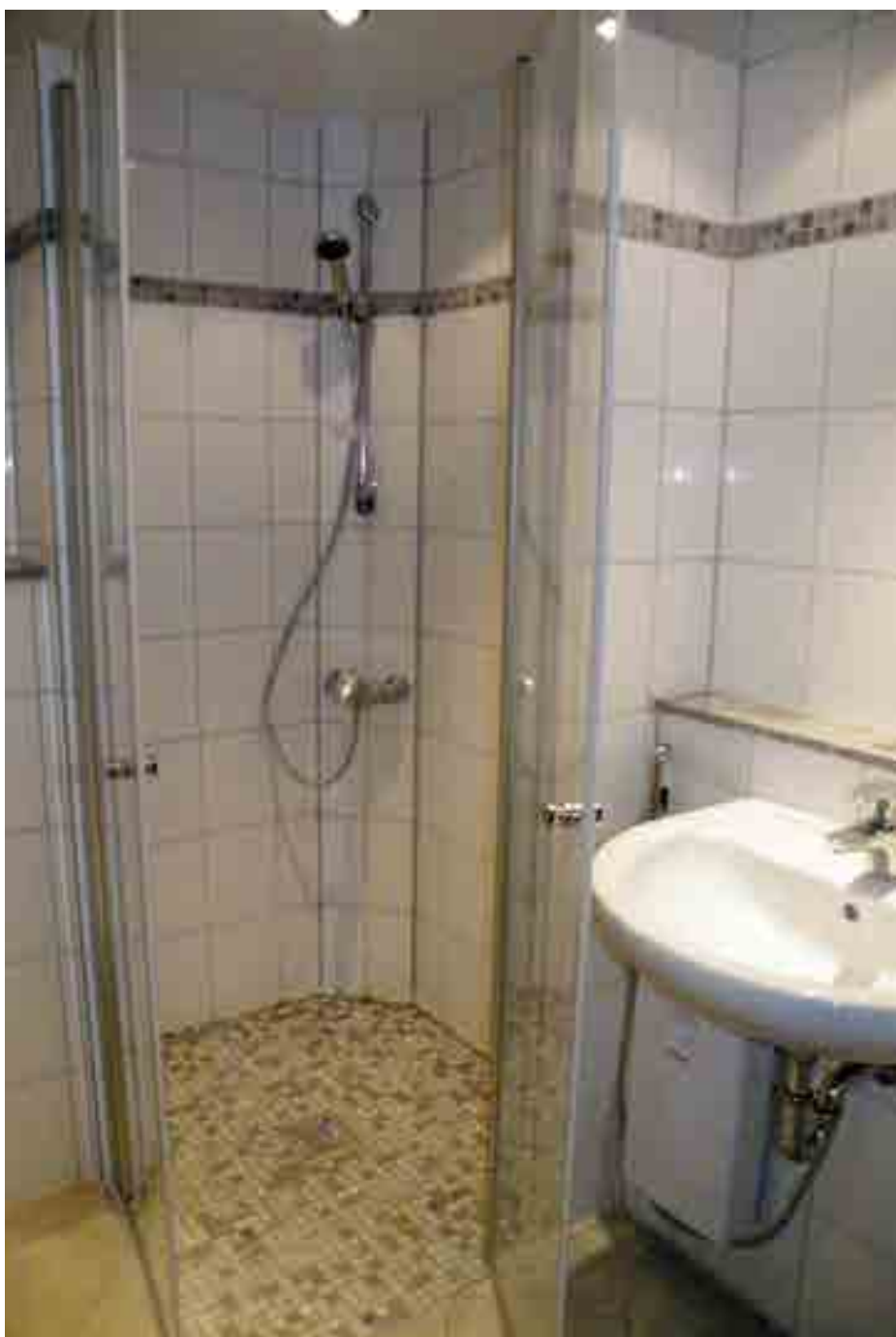
Fertiges Bad mit barrierefreier Dusche
