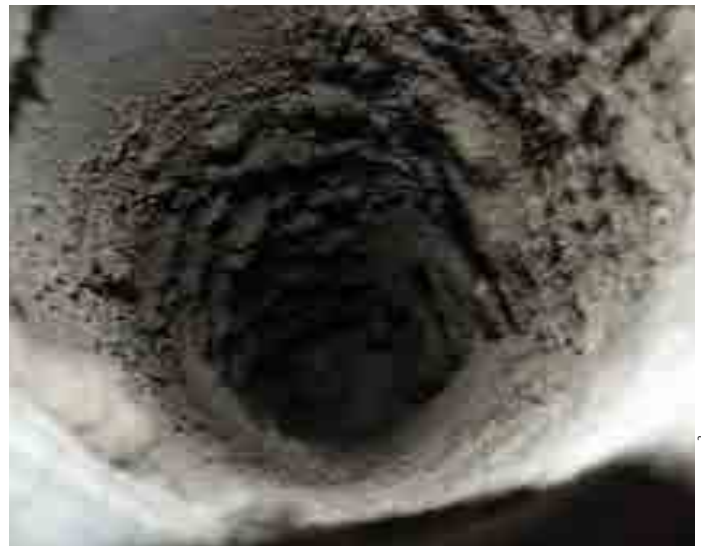
Außenluftsegment zwischen Außenregister und Lüftungsgerät - vor Filterung der Luft. Die Lüftung ist hier in einem absolut nicht wünschenswerten Zustand, in diesem Fall jedoch hygienisch noch unbedenklich, weil danach noch die Filterung erfolgt
