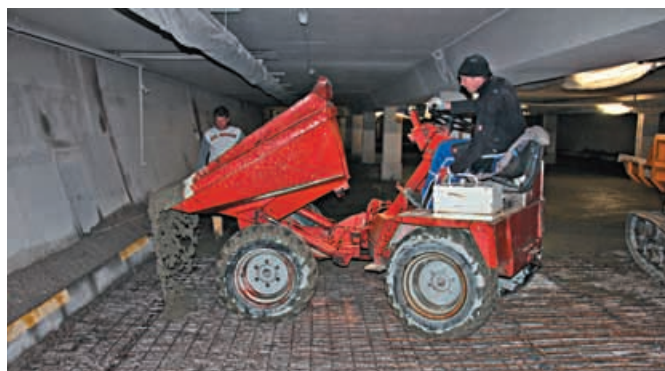
Bild 3: Betoniervorgang mittels Dumper
