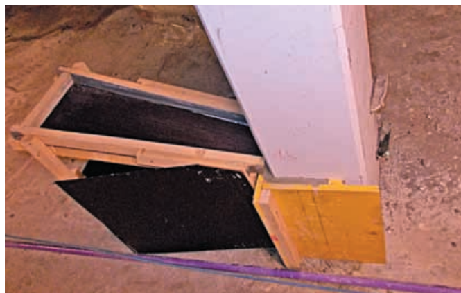
Bild 1: Instandsetzung Stützensockel in jeweils 4 Abschnitten
