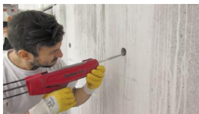
Schritt 3: Einpressen des Injektionsmörtels in die Tragschicht mittels Injektivpistole
