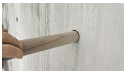
Schritt 1: Kernbohrung (D = 40 mm) und Nachbohren des Ausbruchendes sowie Prüfung der Bohrtiefe mittels einer eigens angefertigten Lehre
