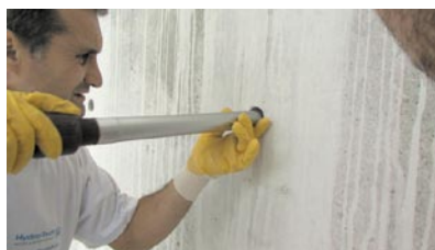
Schritt 1: Kernbohrung (D = 40 mm) und Nachbohren des Ausbruchendes sowie Prüfung der Bohrtiefe mittels einer eigens angefertigten Lehre
