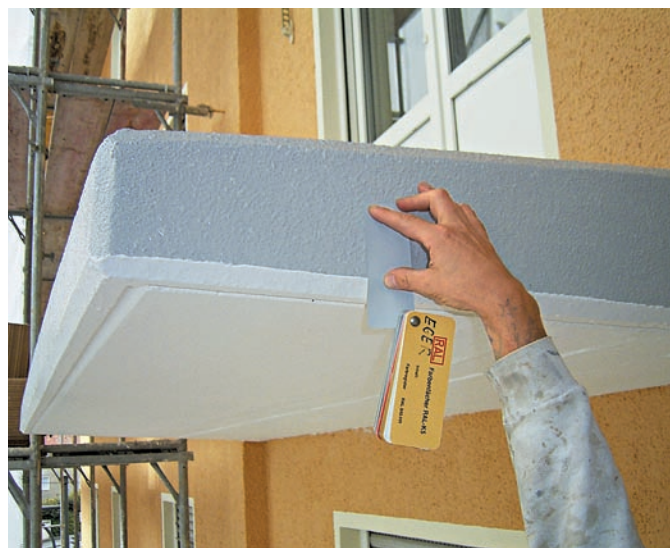
Balkonplatte mit Tropfkante
