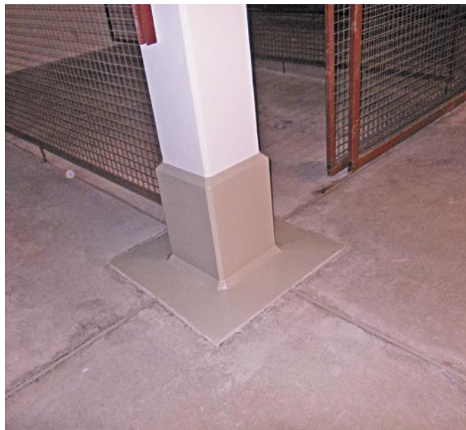
Bild 5: fertig sanierte Stahlbetonstütze
