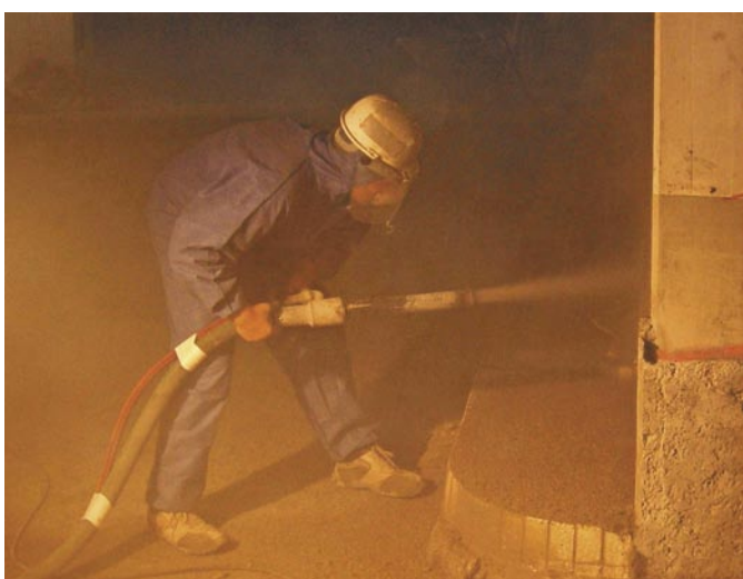
Bild 3: Spritzbetonapplikation mittels Trockenspritzverfahren
