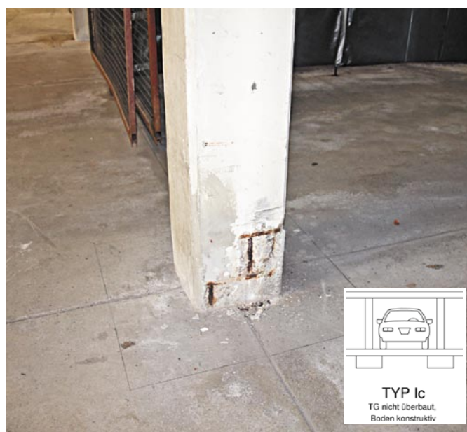
Bild 1: IST - Zustand der Stütze vor Sanierungsbeginn
