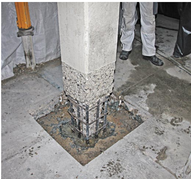
Bild 2: Montage und Kontrolle der Hilfsunterstützung vor Betonabtrag
