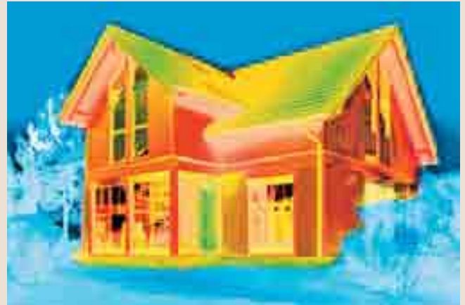
Meist kein Mangel. Ein schlecht gedämmtes Haus.
