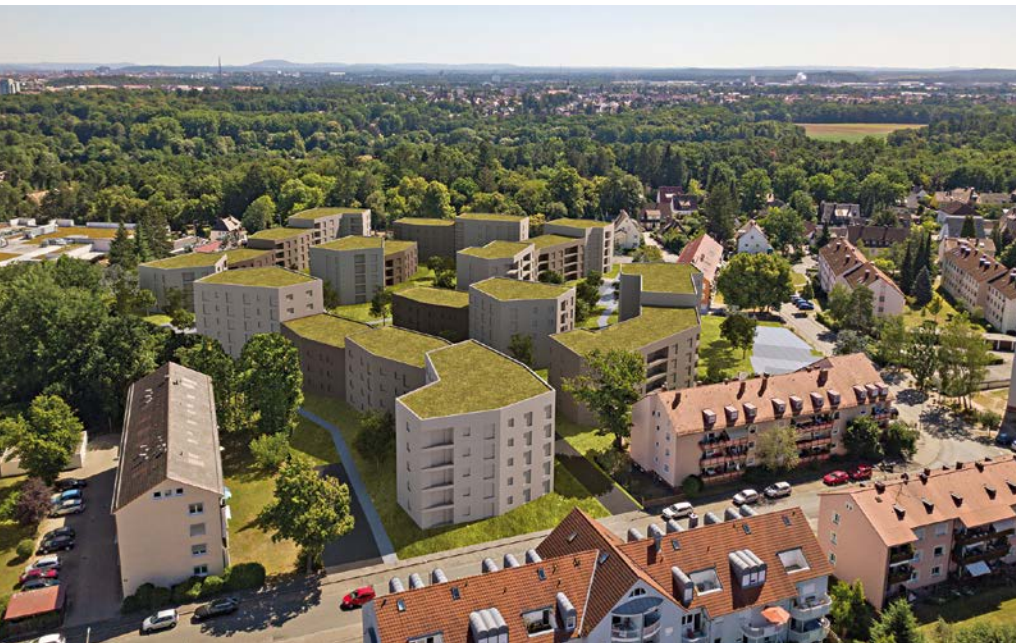
In Stein bei Nürnberg entsteht mit dem Krügelpark ein neues Wohnquartier.
