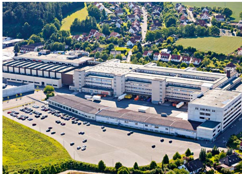
Die logistische Infrastruktur am oberfränkischen Traditionsstandort der Baur-Gruppe in Altenkunstadt wird erweitert.
