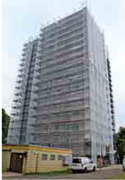
Umrüstung eines Wohngebäudes in ein Passivhaus in Gießen.
