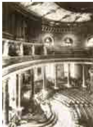
Innenansicht nach der Renovierung 1892
