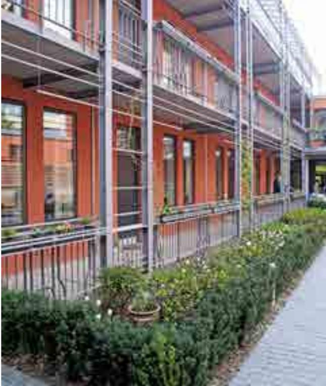
Der Laubengang im Innenhof erlaubt eine barrierefreie Erschließung mit nur einem Aufzug. Außerdem dient er als Ersatz für die Balkone, deren Anbau die Behörden nicht genehmigten
