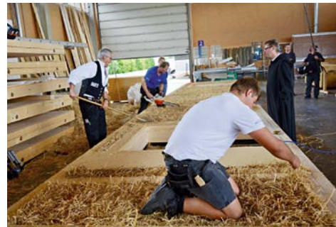
Die Außenwand-Elemente für das Gästehaus des Klosters Plankstetten wurden in der Werkhalle der Zimmerei vorgefertigt – inklusive Strohdämmung
