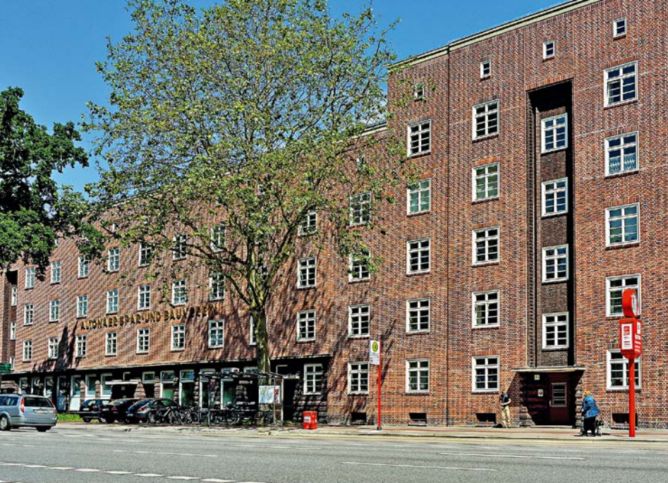
Die sogenannten Reichhardt-Blöcke der Alloba in Hamburg aus den 1930er Jahren wurden 2017 mit PU-Fließschaum für einen besseren Wärmeschutz gedämmt
