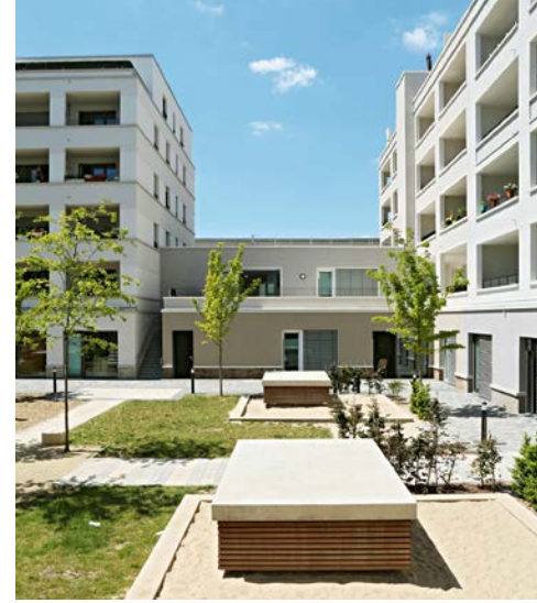
Bei dem in monolithischer Ziegelbauweise erstellten Wohngebäude der GBH in Offenbach verfügen fast alle Wohnungen über Loggia oder Dachterrasse
