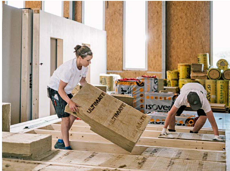
Auch bei vorgefertigten Bauelementen für den Wohnungsbau können nachhaltige Materialien verwendet werden, wie hier eine Holzbau-Dämmung
