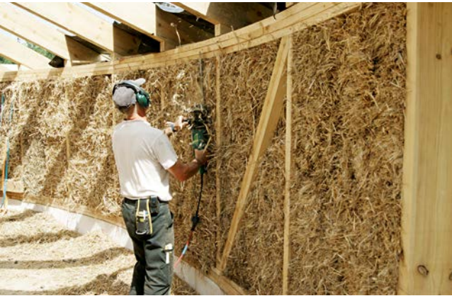
Eine Strohwand wird zum Verputzen vorbereitet. Damit der Lehmputz hält, müssen überstehende Halme gekappt werden
