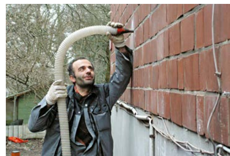
Die Kerndämmung wird über einen Schlauch in eine Außenwand geblasen und füllt dort vorhandene Hohlräume
