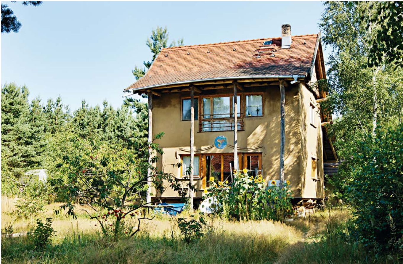
Die Villa Stroh­bunt war seinerzeit das erste zugelassene Strohballen-Wohnhaus Deutschlands. Es wurde ohne Maschinen in reiner Handarbeit errichtet
