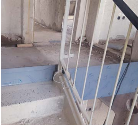
Zum Einbau von Fußbodenheizung und Trittschallschutz, musste der Fußboden in den Stockwerken und im Treppenhaus um 17 cm angehoben werden
