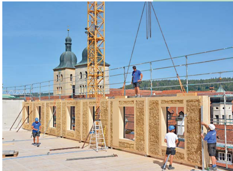
Die vorgefertigten Außenwand-Elemente werden mithilfe eines Krans in das Gebäude eingepasst. Im Hintergrund sind die Zwillingstürme der Klosterkirche in Plankstetten zu sehen
