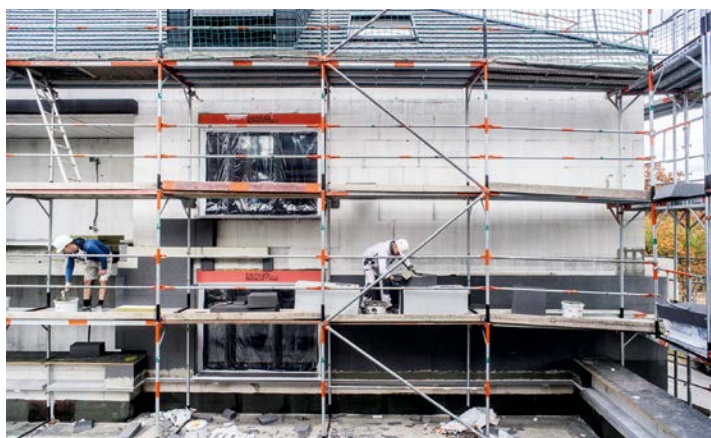
Seit Jahrzehnten hat sich eine Sanierung mit EPS mehr als bewährt
