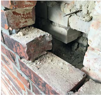
Blick in eine Hohlmauer, die mittels Einblasdämmung verfüllt wird
