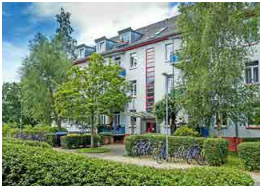
1995 begann der Umbau: Die Kasernengebäude wurden entkernt, große Wohnküchen für WGs eingerichtet und alle Heizungs-, Sanitär- und Elektro-Installationen erneuert
