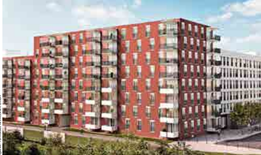
Im Projekt Welfengarten errichtet die Bayerische Hausbau 30 Werkwohnungen. Bis Anfang 2020 soll das Vorhaben in der Münchner Au umgesetzt werden
