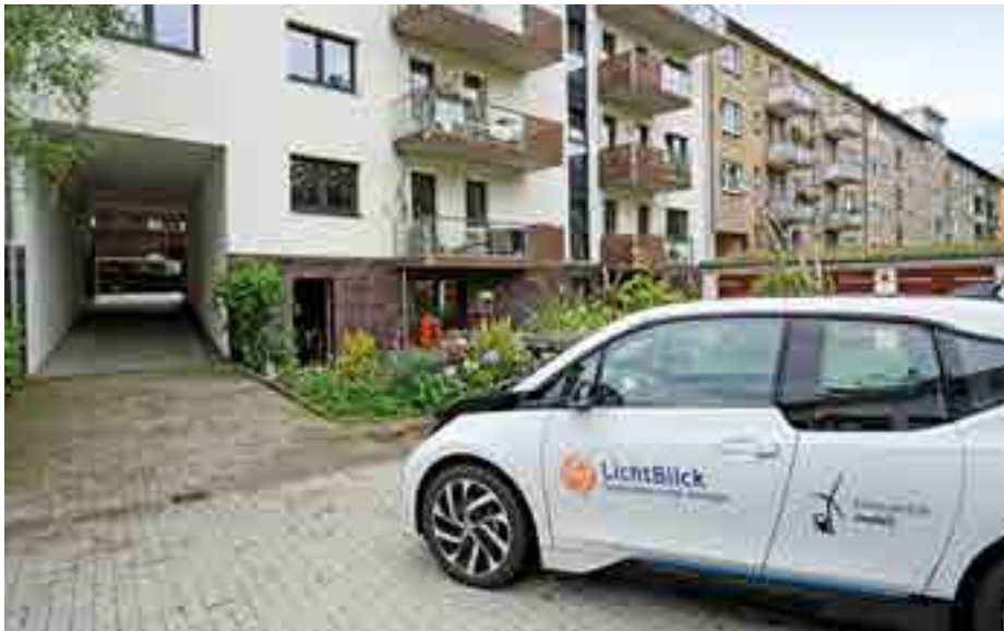
Die drei E im Projektnamen stehen für Eigenerzeugung, Eigenverbrauch und Elektromobilität: PV-Anlagen auf dem Dach, Batterien im Haus, ein Blockheizkraftwerk im Keller und Elektroautos zur gemeinschaftlichen Nutzung
