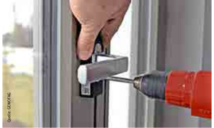
Montage des intelligenten Fensterkontaktes
