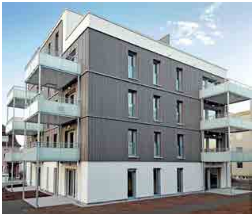
Bauweise der Zukunft: Die Holzhybridbauweise verbindet von jedem Werkstoff das Beste und kombiniert es unter bauphysikalischen, wärme- und schallschutztechnischen Aspekten miteinander
