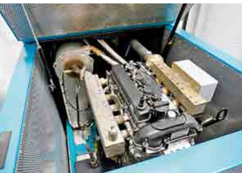
Rund 70% des vom Bauverein Breisgau angebotenen Mieterstroms wird von einem BHKW produziert
