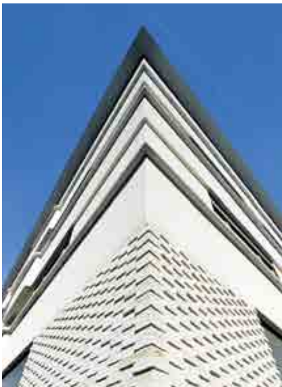
Drei Obergeschosse in monolithischer Ziegelbauweise mit Verglasungen und unterschiedlichen Putzstrukturen wurden auf den Klinkersockel mit erhöhtem Erdgeschoss gesetzt
