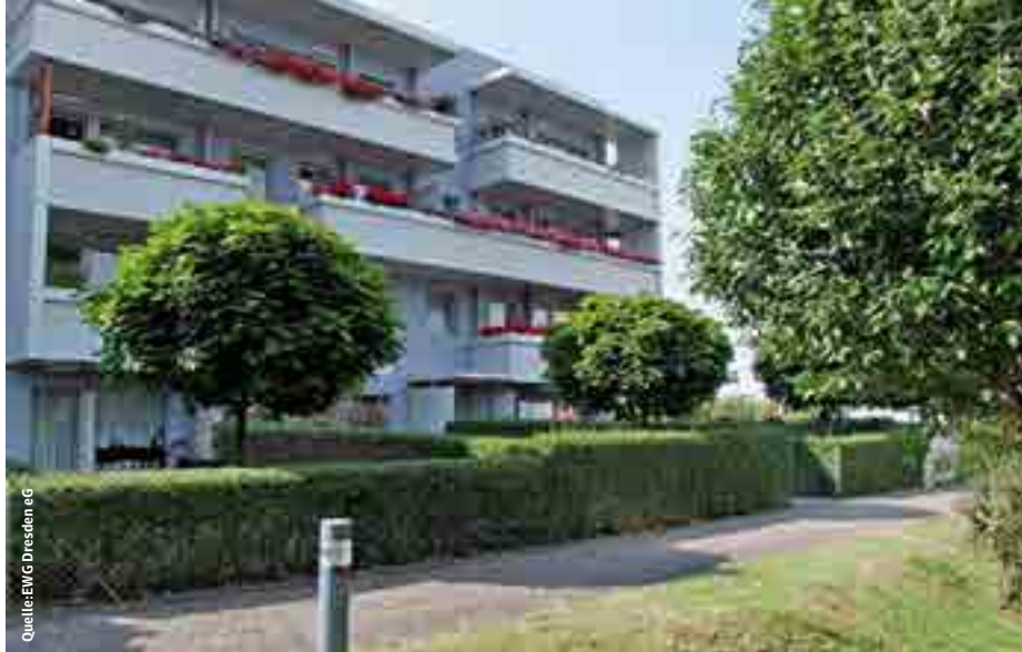
Die Kräutersiedlung nach dem Umbau
