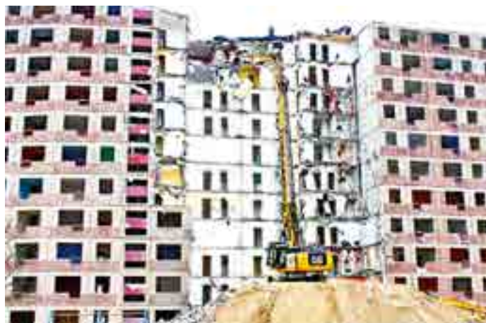
Der Abriss am Juri-Gagarin-Ring hat bereits begonnen
