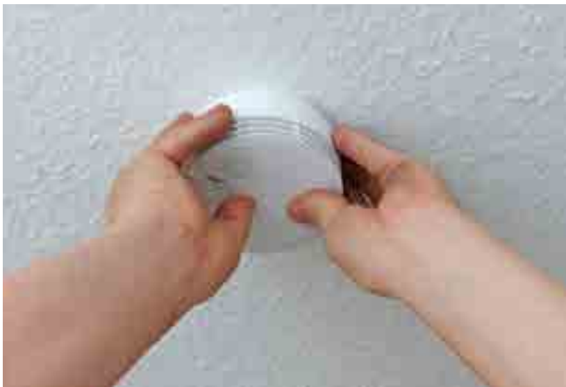
Oben: Installation eines Rauchwarnmelders Rechts: Die Neues Berlin setzt beim Einbau und bei der Wartung der Rauchwarnmelder auf eigenes Personal
