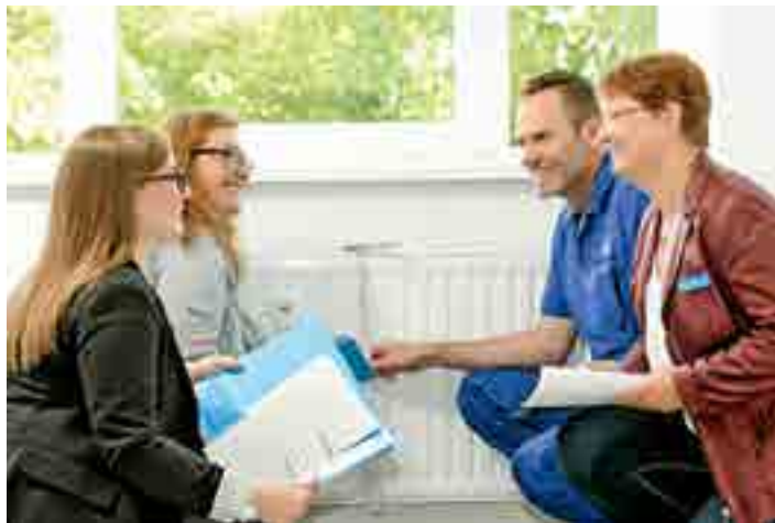
MWB-Techniker und -Mitarbeiterinnen beim Einbau eines Ablesegeräts
