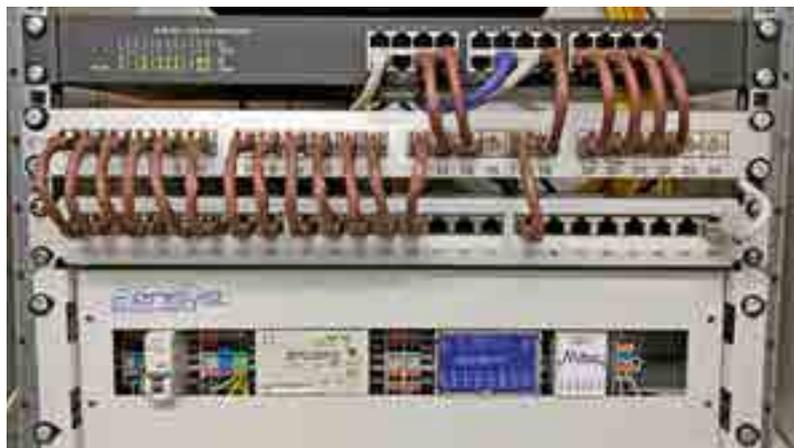
Steuerungsmodul mit Webanbindung in der Energiezentrale des Neubaus
