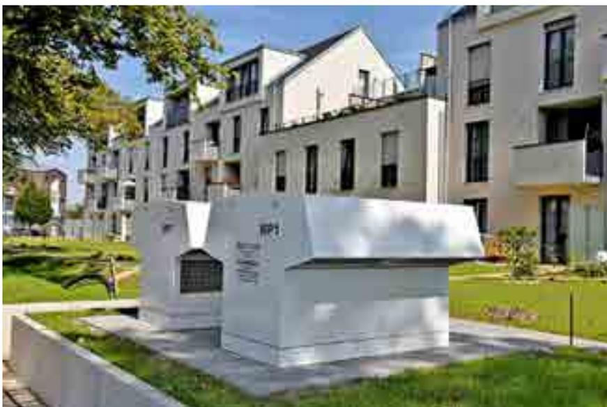
Großwärmepumpen kommen als Heizungsanlagen auch bei großen Gebäuden zum Einsatz - hier zwei Luft-Wasser-Wärmepumpen, die in Ludwigsfelde einen Komplex aus fünf Mehrfamilienhäusern mit insgesamt 44 Wohneinheiten mit Wärme versorgen
