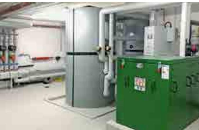
Blockheizkraftwerk, Pufferspeicher und Heizungsverteiler in der Energiezentrale des Neubaus
