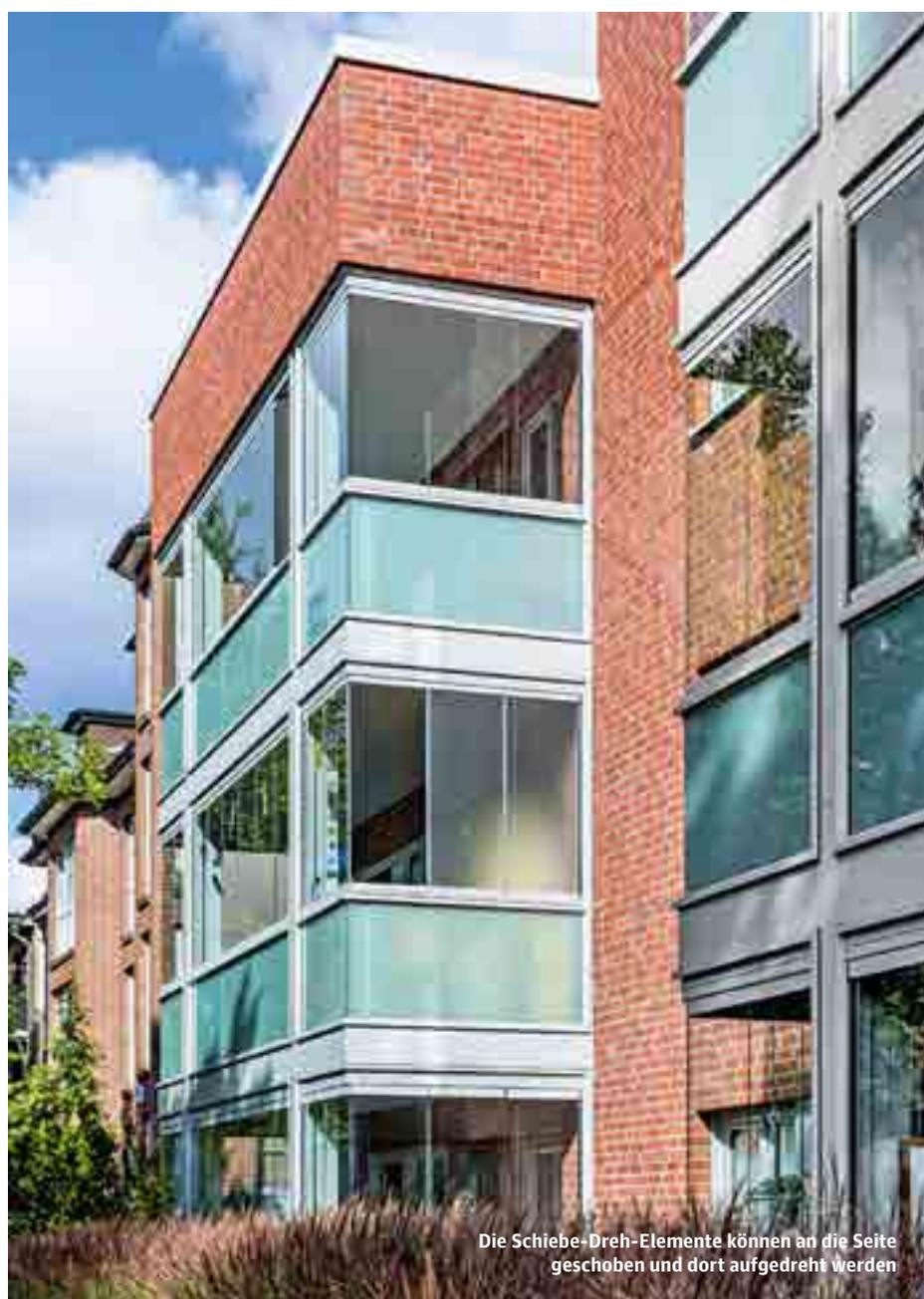
Die Schiebe-Dreh-Elemente können an die Seite geschoben und dort aufgedreht werden
