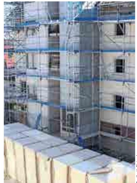
Bestehendes Mehrfamilienhaus der FEWOG in Fellbach bei Stuttgart: Energetische Sanierung durch Dämmung der Gebäudehülle nach dem Standard KfW-Effizienzhaus 85
