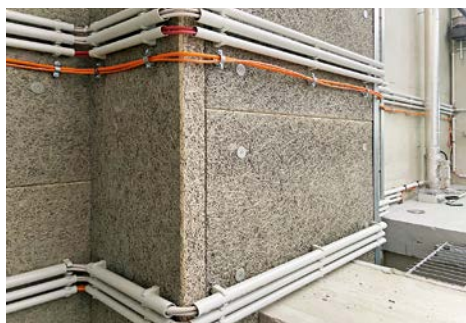
Zementgebundene Holzspanplatten, in der DDR als „Sauerkrautplatten“ das einzig verwendungsfähige Dämmmittel, erleben wieder eine Renaissance als alternativer Dämmstoff
