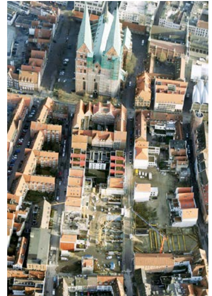
Baumaßnahmen im Lübecker Gründungs- viertel zwischen der Kirche St. Marien und der Untertrave aus der Luft
