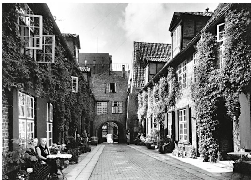
Der früher den Witwen von Seefahrern und Kaufleuten vorbehalten Glandorps Gang in der Glockengießerstraße vor seiner Sanierung
