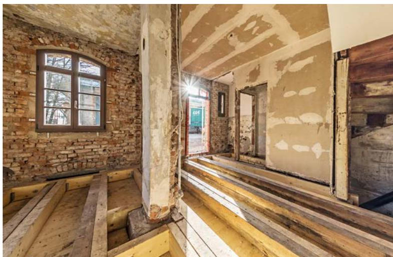
Innensanierung mit Aufbau des neuen Fußbodens. Die historischen Balken wurden mit zusätzlichen neuen, tragfähigen Balken ergänzt
