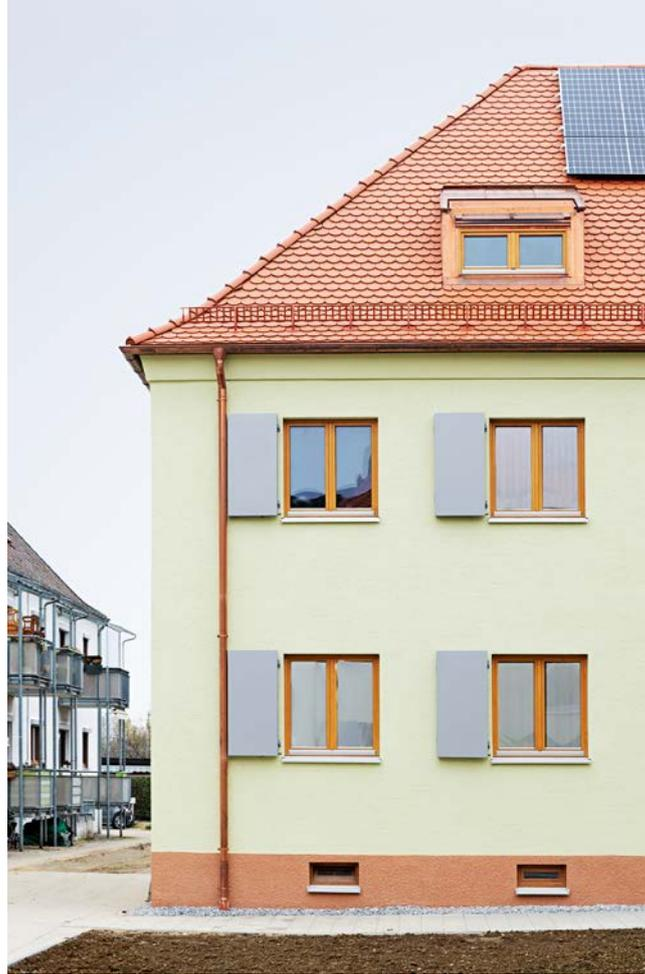
Die mineralische Spritzdämmung harmoniert optisch, haptisch und hinsichtlich der Materialität sehr gut mit der historischen Bausubstanz
