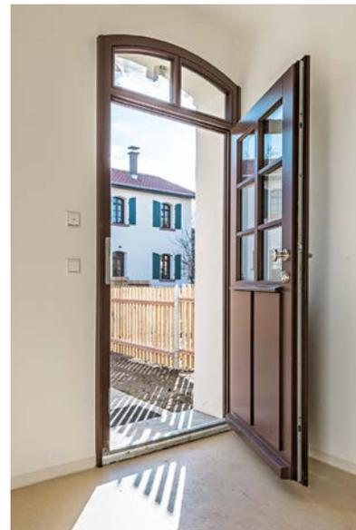
Die Knopfhäusle wurden mit Wärmeputz von außen gedämmt und erhielten in Abstimmung mit dem Denkmalschutz neue Fenster, Türen und Außenbeleuchtungen
