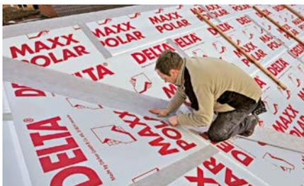
Mit Aufdachdämmelementen werden energetisch zukunftssichere Konstruktionen ermöglicht
