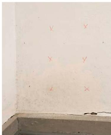
Bild 3: Keine liquiden Ränder, jedoch über der Sockelleiste zur Wanddecke leichte Verfärbungen. Typisches Schadensbild für Kondensatfeuchte
