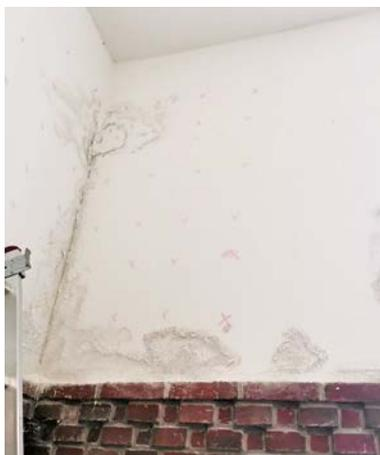
Bild 2: Starke Feuchteschäden. Das Schadensbild ist typisch für „fließende Feuchte“. Liquide Feuchteränder und starke Versalzung sichtbar
