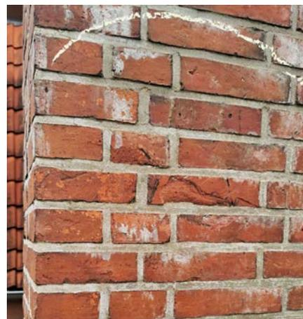
Bild 4: Kalkaussinterungen deuten auf Fehlstellen in der Verfugung hin. So dringt Wasser ein und löst schwerlösliche Kalke aus dem Mörtel. Frostschäden auf dem Ziegel sind sichtbar
