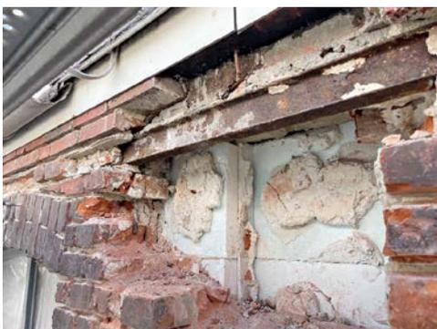
Bild 7: Eine größere Bauteilöffnung an der Außenfassade kann stark korrodierte Träger freilegen und zum Beispiel eine mangelhafte Verklebung der Dämmplatten deutlich machen
