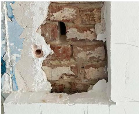
Bild 6 (oben): Bei der kleinen Bauteilöffnung an der Innenwand rieselte Sand heraus
