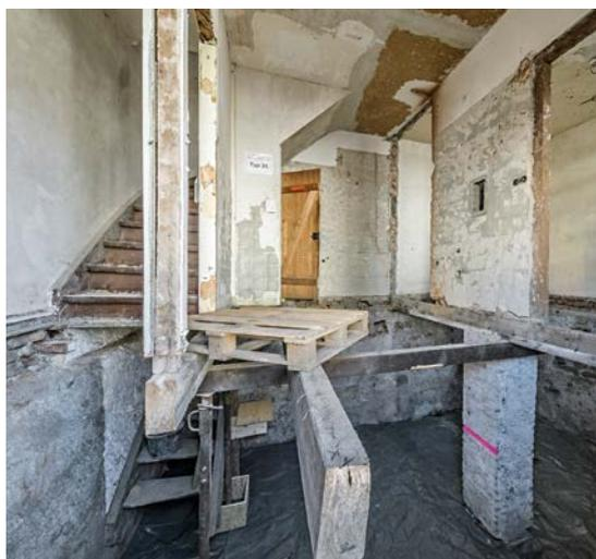
Die Kellerdecke mit der Schlackeaufschüttung wurde ebenso entfernt wie die maroden, historischen Balkenteile
