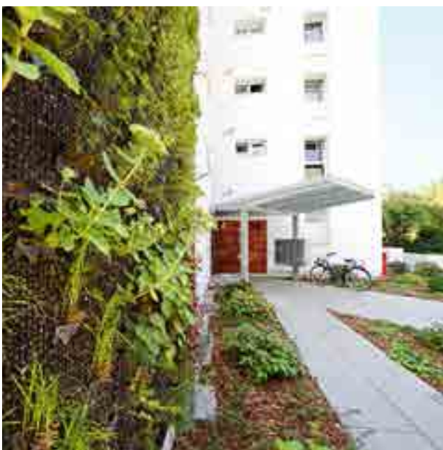
Auch der Außenraum wurde erneuert. Zusammen mit der Fassadenbegründung entsteht ein ganz neuer Eindruck
