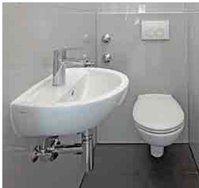
Gäste-WC nach der Badsanierung
