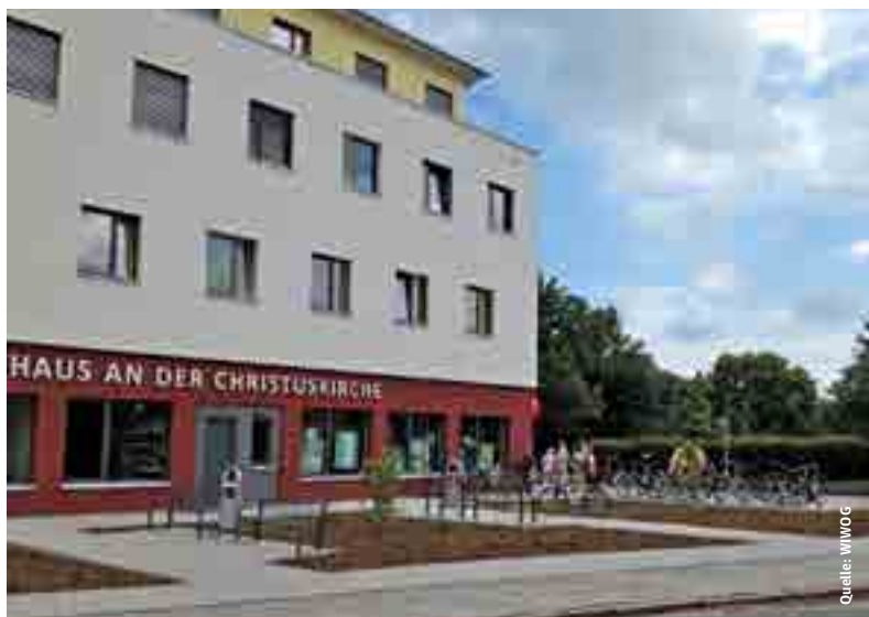
Im Juli 2014 eingeweihter Neubau des Ärztehauses in Wittenberg-West: 2,9 Mio. € investierte die WIWOG. Steigende Projektanforderungen erfordern gut ausgebildete Fachkräfte
