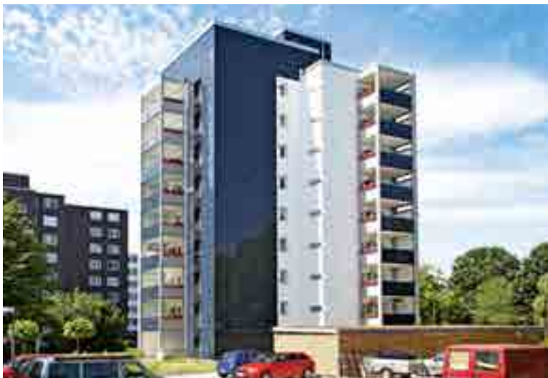
Dämmung, Solaranlage und neue Vorstellbalkone haben das Aussehen komplett verändert. Innen sorgen eine Lüftungsanlage und eine erneuerte Aufzugsanlage für mehr Wohnkomfort
