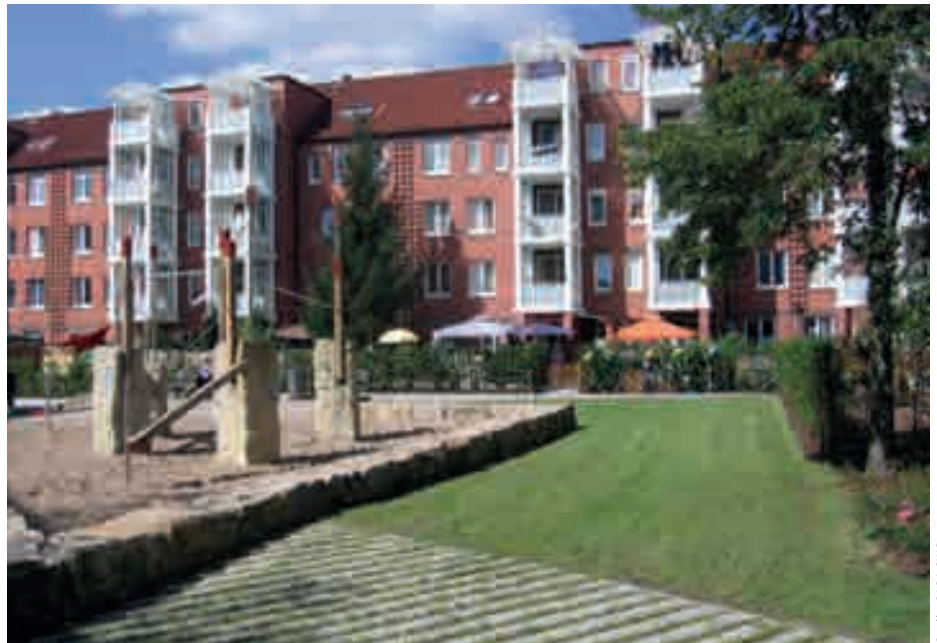
Das rund 30 Jahre alte Quartier in Hamburg-Langenhorn war erneuerungsbedürftig. Die Grün- und Freiflächen wurden unter aktiver Beteiligung der Bewohner umgestaltet, neue Kunstobjekte wurden errichtet
