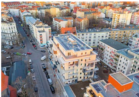
Viele Dachflächen ermöglichen Mieterstromprojekte, doch die Einbindung in die Gebäudesteuerung ist nicht trivial
