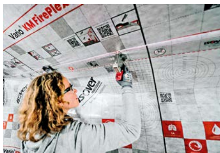
Isover hat die weltweit erste schwerentflammbare Klimamembran entwickelt
