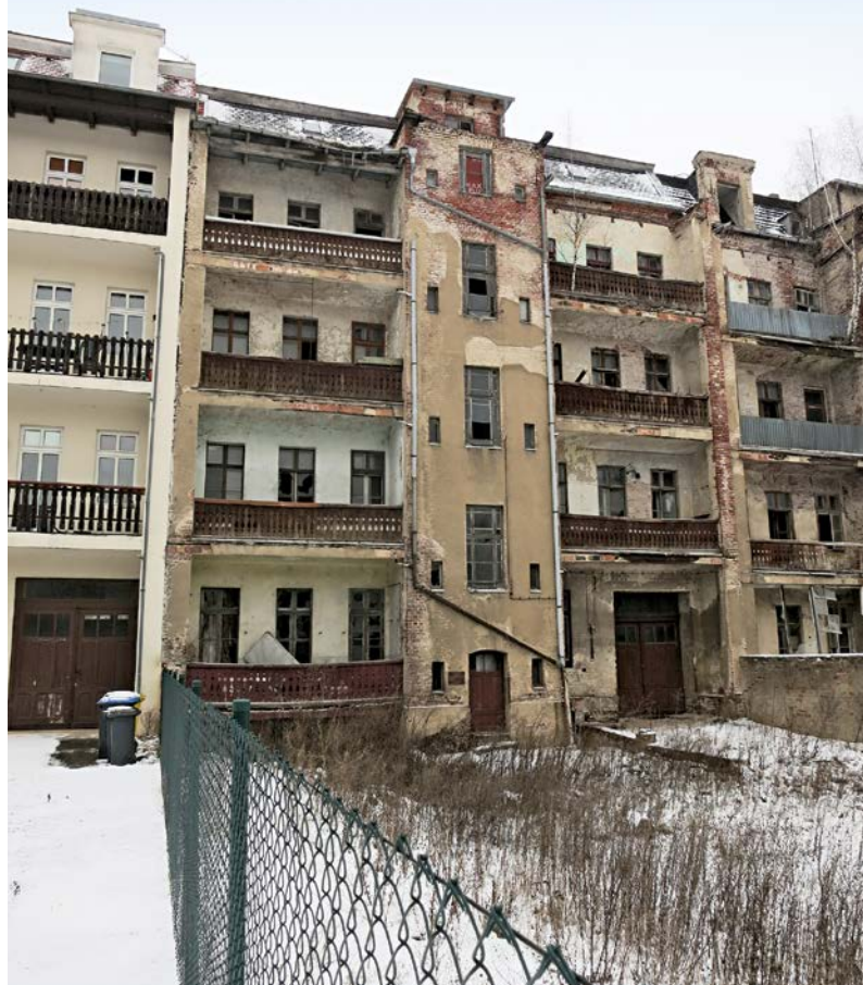
So sah der Hof der Brautwiesenstraße 18 vor der Sanierung aus ...
