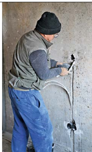
Grundsanierung: Die WIS investiert in Lübbenau
