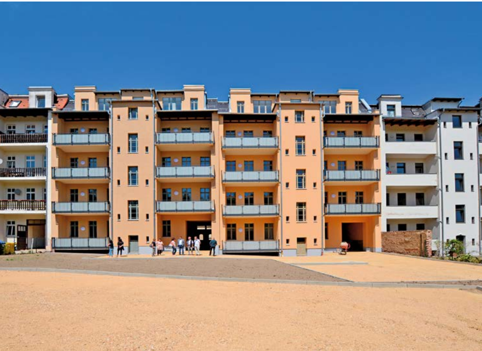
... und so nach der umfangreichen Modernisierung
