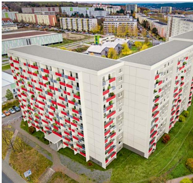
Die bisherigen Balkon-Brüstungen aus DDR-Zeiten in Richtung Erlanger Allee und Uniklinikum werden für alle neu entstehenden Wohneinheiten durch eine moderne Metallkonstruktion ersetzt
