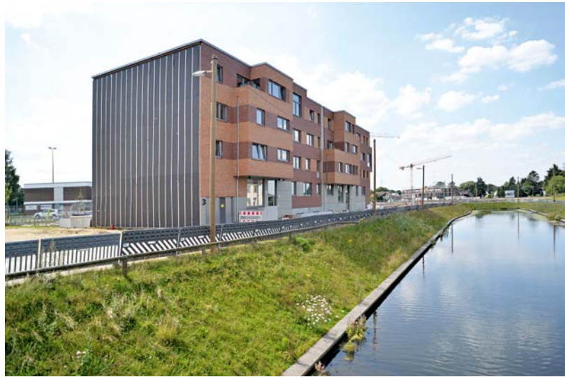
Das Haus der Baugemeinschaft „Jenfelder Au“ wurde als eines der ersten bezogen. Hier wird das geschlossene WC-System genutzt. Auch die BPD Bouwfonds Immobilienentwicklung installierte es im 2. Bauabschnitt des Projekts „Ja! Jenfelder Au“
