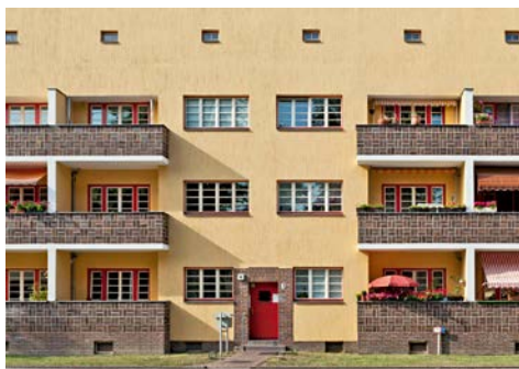
Die Gebäude sind auf Grünanlagen oder große Wohnhöfe ausgerichtet. In den Drempelgeschossen sind Trockenböden untergebracht
