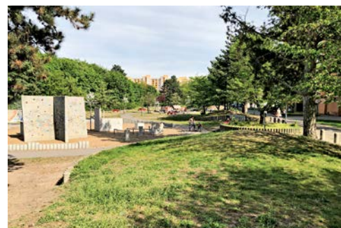
Der Blick in den großen inneren Freiraum zeigt die Großzügigkeit des Wohnumfeldes als Gegenpol zur vielgeschossigen Bebauung
