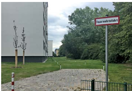
In der John-Locke-Siedlung wurden Verkehrsflächen aus Rasenkammersteinen gebildet, die nun wie Rasenflächen aussehen
