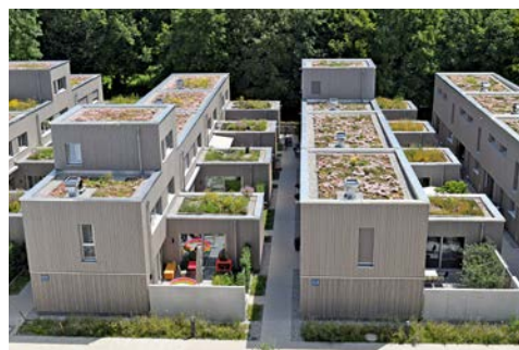
Intensive Dachbegrünungen erfordern weniger Investitionen und weniger Pflegeaufwand, werden aber nicht so häufig gefördert
