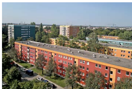
Diese 50 Jahre alte Wohnanlage in München wurde energetisch modernisiert: Die alten Gaskessel wurden durch eine Biomasseanlage ausgetauscht
