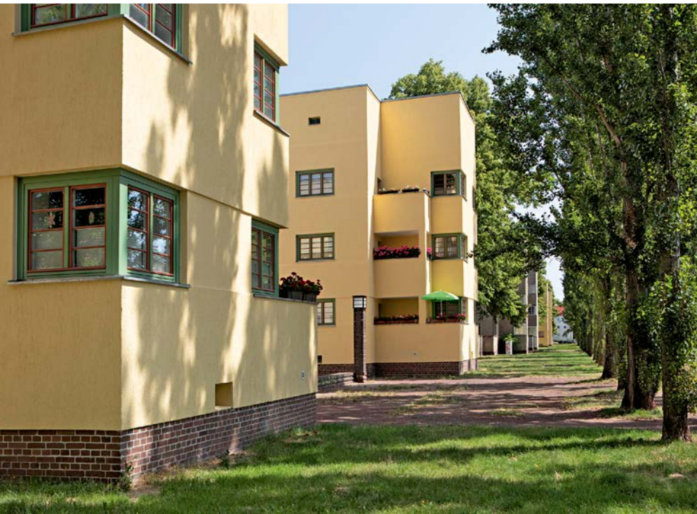
Da komplexer Sanierungsbedarf bestand, erfolgt seit den 1990er Jahren eine schrittweise denkmalgerechte Aufwertung. So wurden Elektroanlagen, Türen und Fußböden erneuert, die Bäder teilweise vergrößert sowie Fassaden saniert. Die Grünanlage hat heute parkähnlichen Charakter
