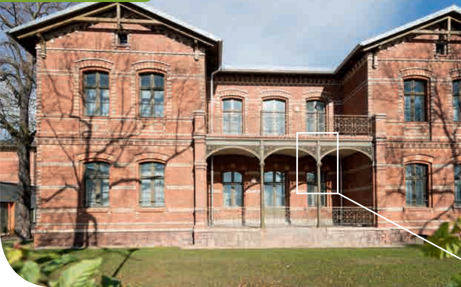
Auf dem Gelände einer ehemaligen Heilanstalt errichtete die GWG Halle-Neustadt ein moderne Anlage für das Kurzzeitwohnen. Sanierte Altbauten und neu errichtete Ergänzungs- und Verbindungsbauten bilden nun eine spannende Einheit
