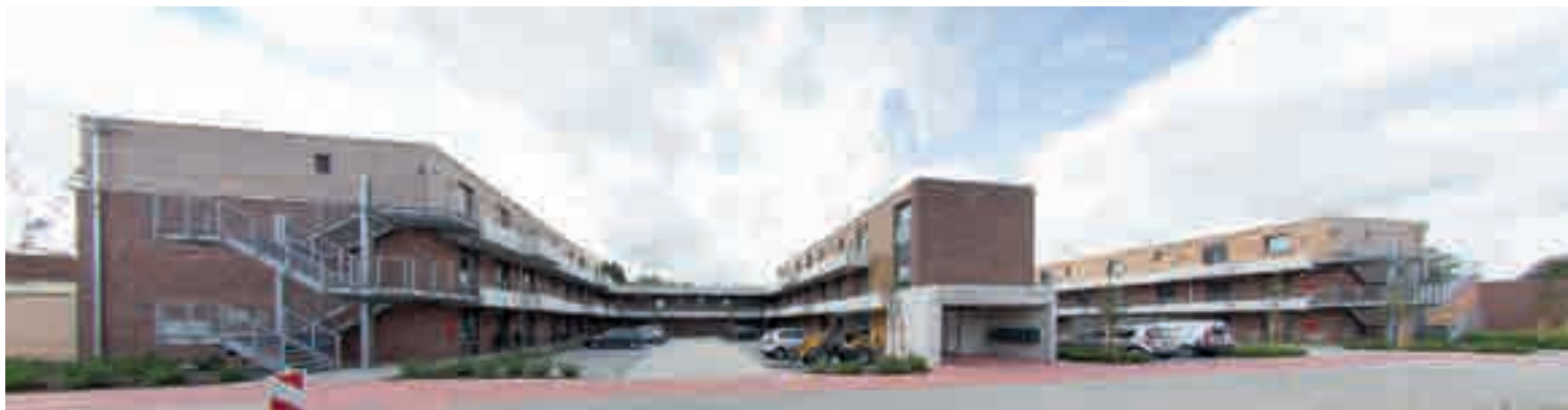
Panoramaaufnahme in die Wohnanlage
