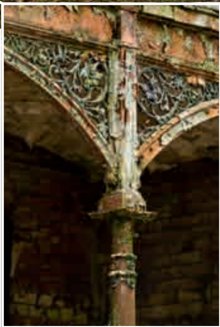
Liebevoll wurden selbst abgängige und verwitterte Details erneuert
